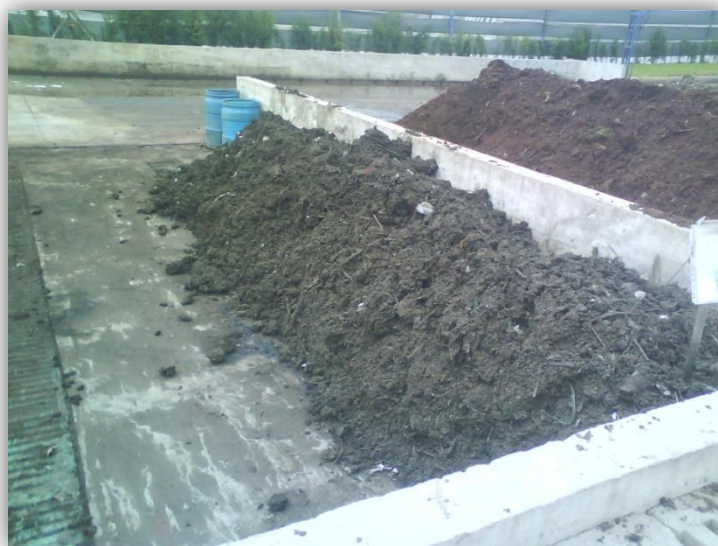
Figura 27 Tanques de recepción
