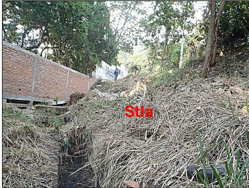
Fotografía 13. Barrió San Cristóbal. Visto al NE, Panorámica de la zona de estudio en la cual se aprecia ladera y canalización de agua sobre suelo de llenos antrópicos (Stla).
