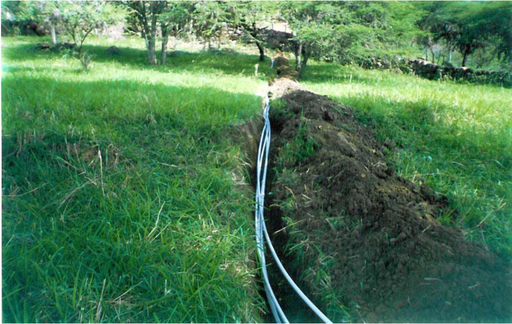
Foto 3. Excavación y conducción Domiciliaria
