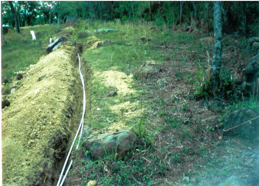
Foto 2. Excavación y Conducción domiciliaria
