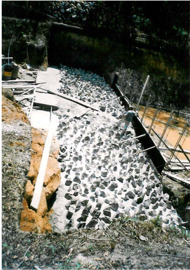
Foto 2. Construcción cuerpo de la presa en concreto ciclópeo.
