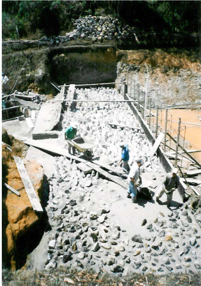
Foto 3. Construcción cuerpo de la presa en concreto ciclópeo.
