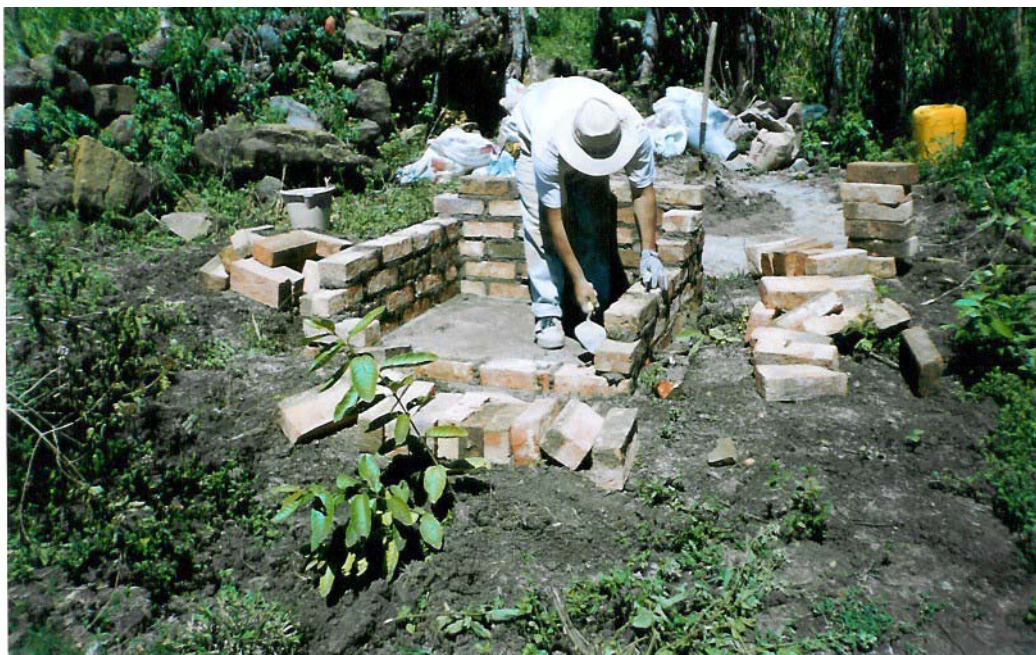
Foto 5. Construcción tanquilla de distribución.
