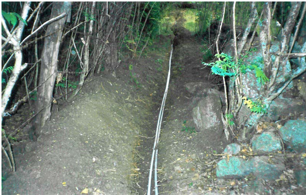
Foto 4. Excavación y Conducción domiciliaria
