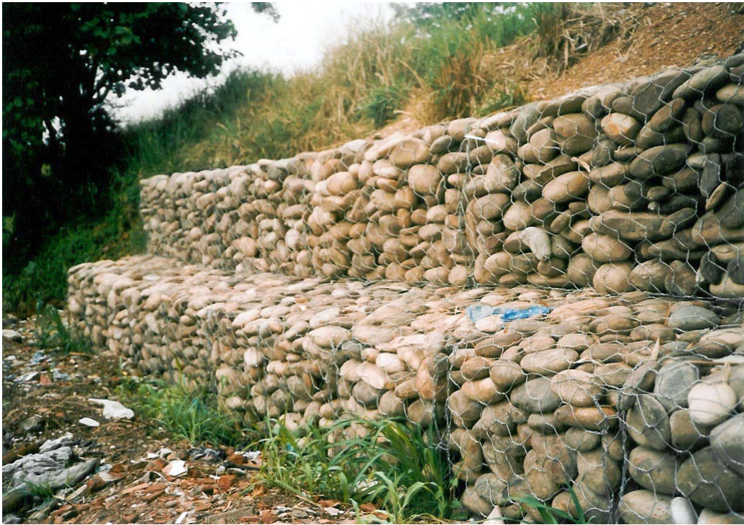
Foto 7. Obras de Protección en gavión para el control de la erosión.
