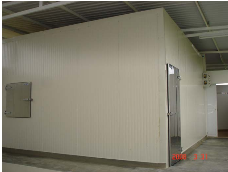
Foto 10. Montaje del Cuarto Frío
