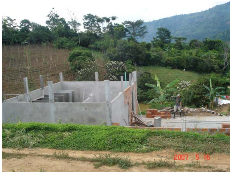
Foto 9. Construcción de la sección de baños y el cuarto frío.
