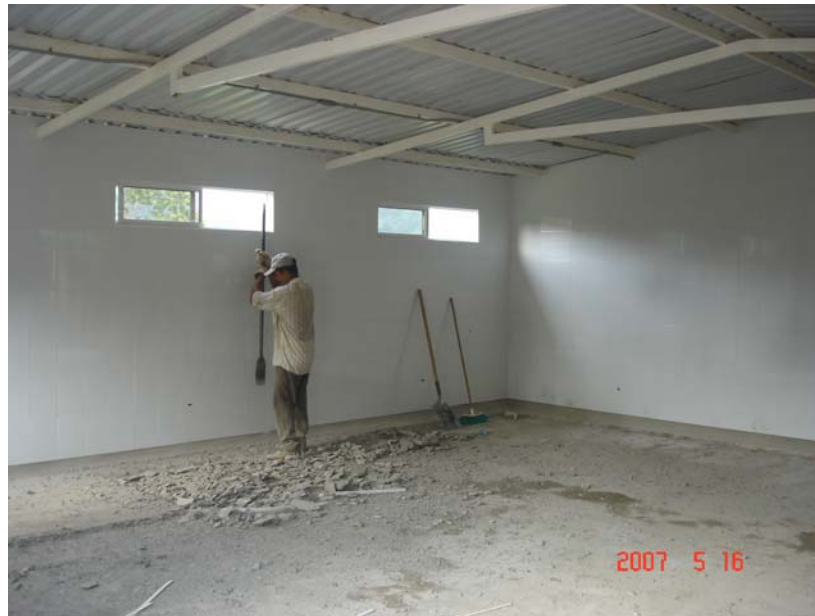
Foto 7. Construcción de la planta de desmotado.
