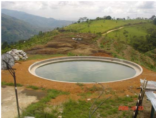
Foto 2. Tanque de almacenamiento
