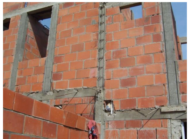
Fotografía N° 5. Casa 21 y 22 de la manzana de la etapa 9 Presentan junta, mientras que en las casas anteriores de la misma manzana no la presentan. Fuente El Autor
