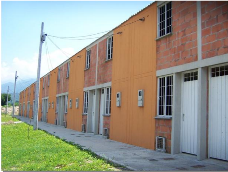
Fotografía N° 2. Fachada de viviendas del proyecto Villas de San Ignacio. Fuente El autor
