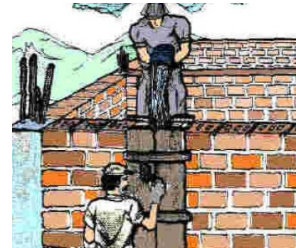
Vertimiento de concreto
