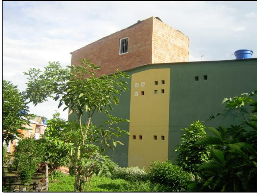
Fotografía N° 9. Vivienda que violó normas de construcción al construir tercer piso. Fuente El autor
