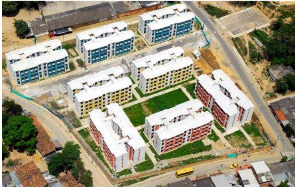
Fotografía Nº 10. Proyecto de viviendas de interés social La Estación. Fuente INVISBU
