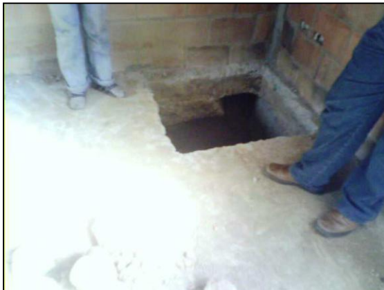
Fotografía N° 7. Sondeos en el interior de vivienda. Fuente El autor.
