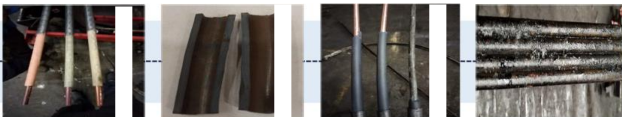
Figura 10. Condiciones físicas durante remoción de armadura.
