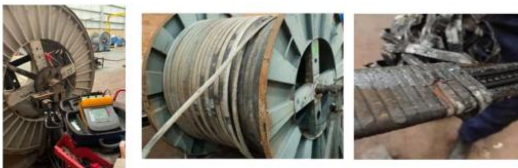
Figura 8. Etapa de inspección cable
