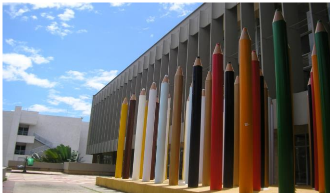
Figura 2. Vista exterior del edificio Biblioteca
