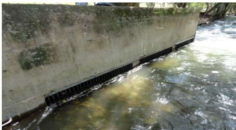
Figura 39: Bocatoma
