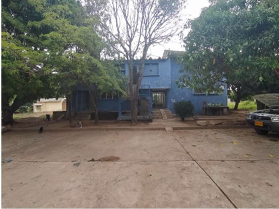
Figura 55: Edificio de Operación
