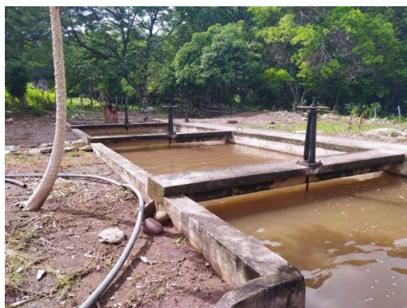
Figura 41: Desarenador
