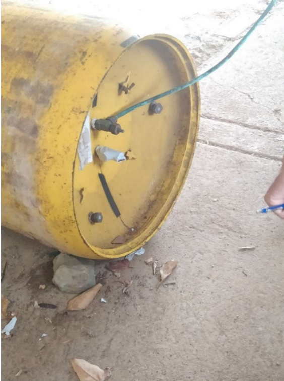
Figura 35: Tanques de cloro
