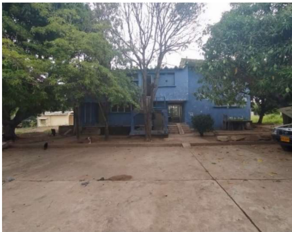
Figura 28: Edificio de Operación
