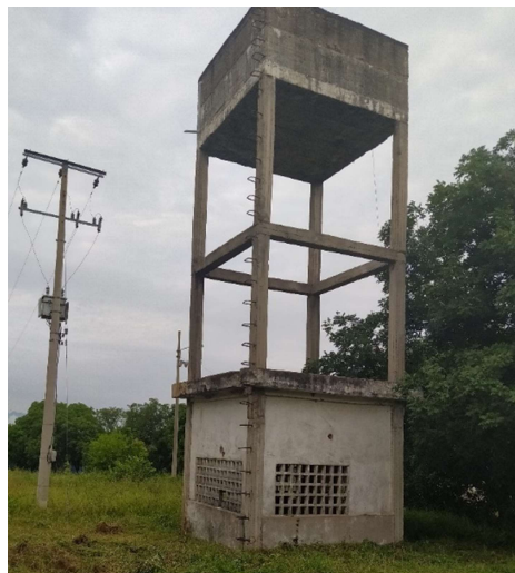
Figura 23: Tanque Elevado
