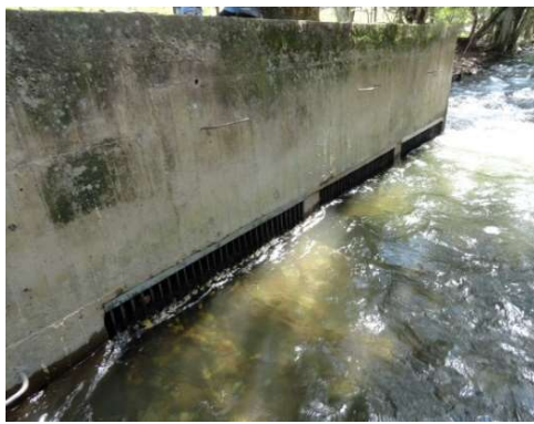
Figura 11: Bocatoma
