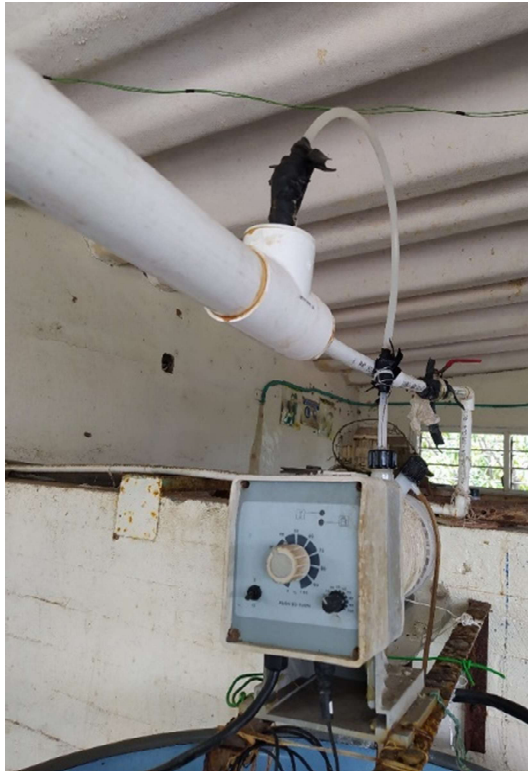
Figura 16: Dosificador EMEC
