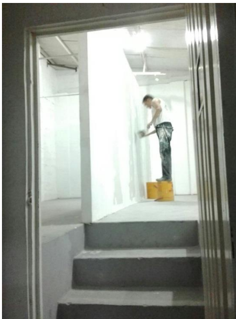
Figura 9. Adecuación del espacio para el montaje del proyecto. Muro en Drywall 27
