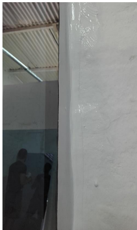
Figura 17. Fotografía montaje sobre mampostería rústica_ 32
