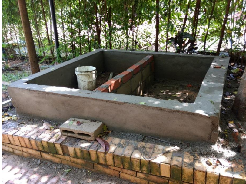
Figura 39. Sitio en adecuaciones para realizar el compostaje de manera adecuada.
