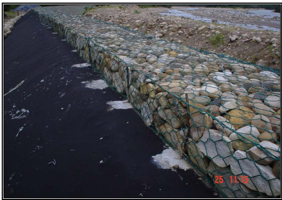
Fotografía 95. Geotextil y bloques de protección del dique contra la socavación.
