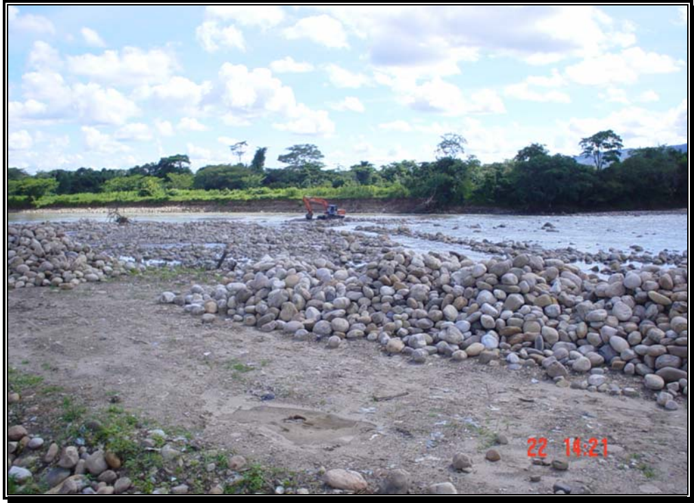
Fotografía 93. Material seleccionado con maquinaria o de forma manual para el colchón reno.
