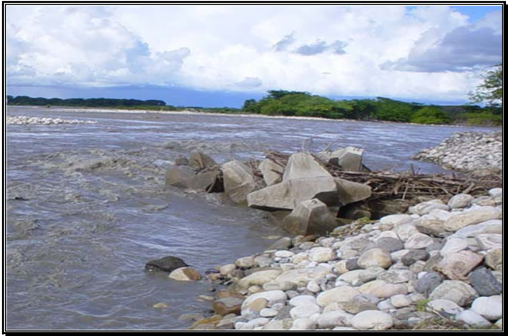
Fotografía 45. Restos del dique construido con material del río para defender la urbanización La Casa del Río después de las crecientes de mayo - 2004.
