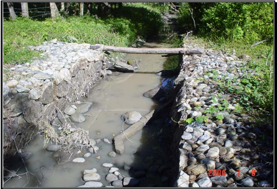
Fotografía 29. Gaviones para proteger el talud del canal El Remanso.
