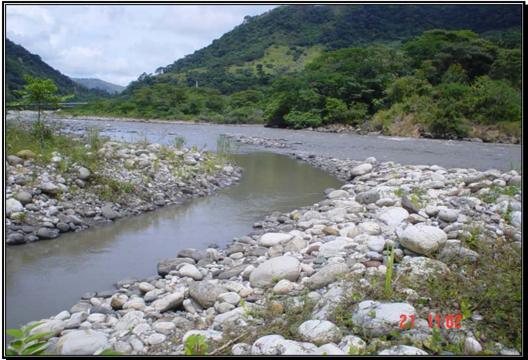
Fotografía 47. Bocatoma para la entrada de agua en época de verano a los caños del parque La Iguana. Jarillón que desvía las aguas al interior del canal.
