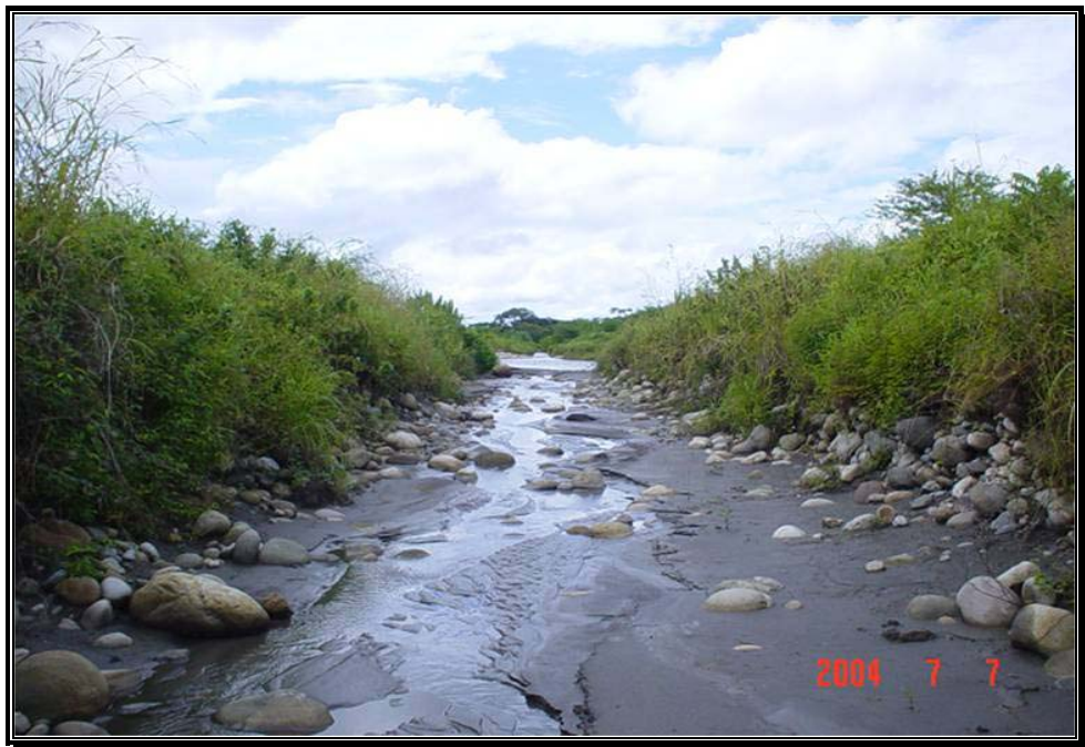
Fotografía 76. Canal recto que une las barras No 17 y la No. 20. Diques con material suelto del río para formar los canales, con una altura de dos a tres metros aproximadamente.
