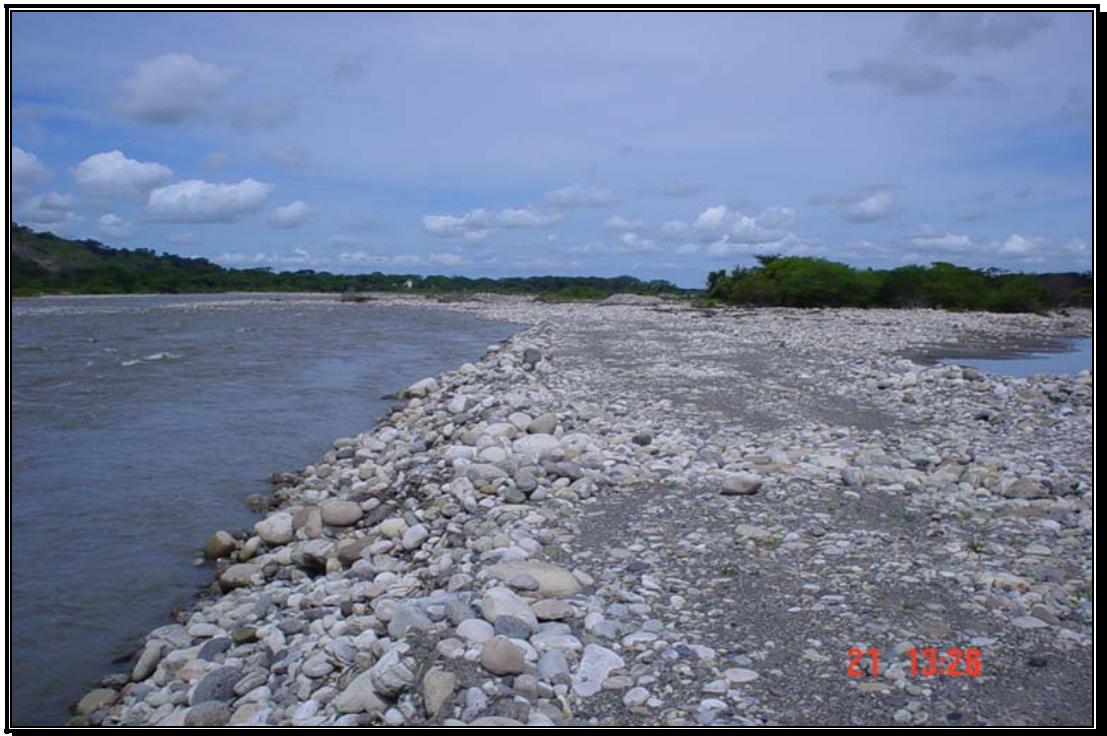
Fotografía 43. Filtración por la base del dique construido con material del río para defender la urbanización La Casa del Río en el mes de mayo - 2004.
