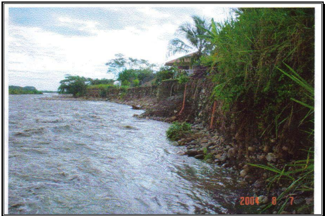
Fotografía 45. Restos del dique construido con material del río para defender la urbanización La Casa del Río después de las crecientes de mayo - 2004.
