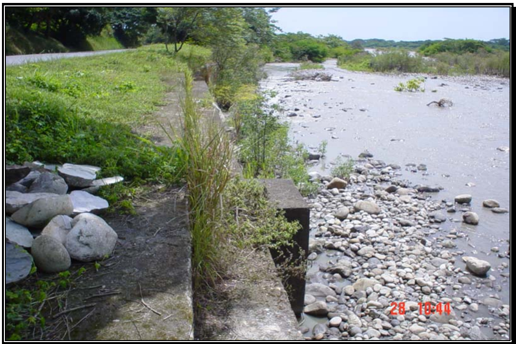
Fotografía 68. Gavión en concreto construido para proteger la margen izquierda del río Cravo Sur frente a la barra No. 3.
