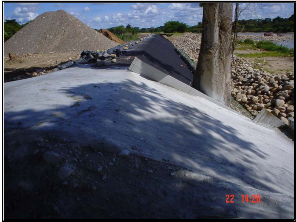
Fotografía 89. Tramo inicial del dique. Estructura de unión al talud mediante un recubrimiento en cemento.
