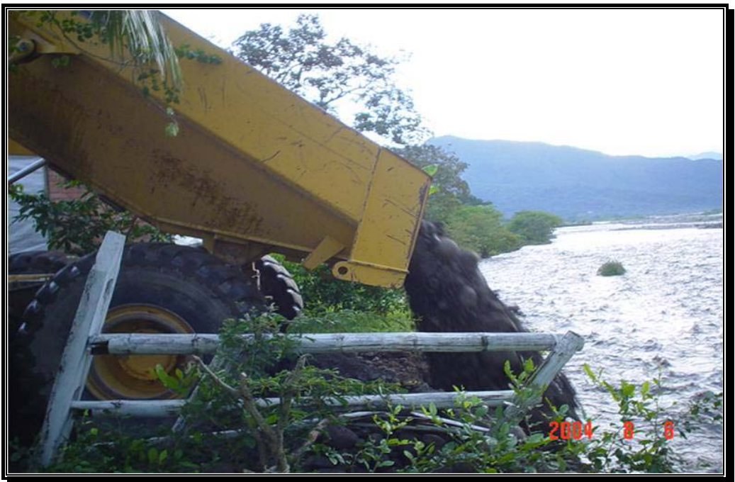
Fotografía 98. Colocación de material conformado por sobretamaños en la base del talud de La Casa del Río.
