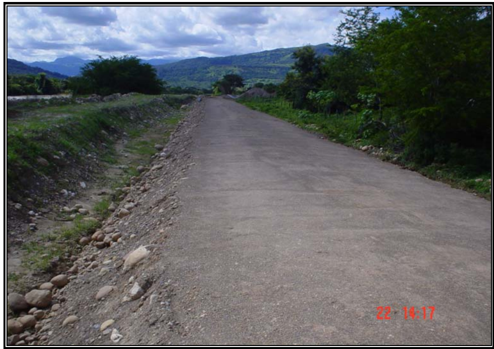
Fotografía 92. Proceso de apisonamiento de las capas del dique.
