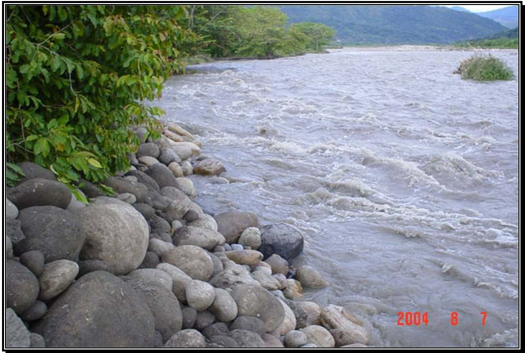
Fotografía 99. Sobretamaños en la base del talud para apartar el flujo al paso de la creciente de agosto de 2004.
