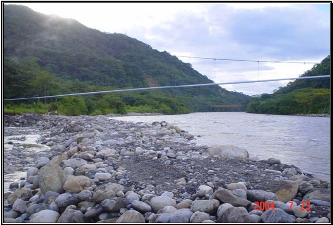
Fotografía 25. Dique con material grueso y sobretamaños para cerrar el brazuelo de la margen derecha donde se colocó la barra artificial.
