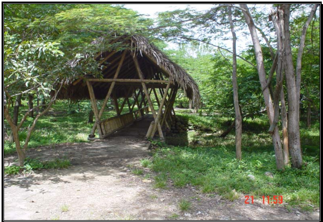
Fotografía 54. Puentes en guadua construidos sobre el caño No. 2, dentro de la barra del parque La Iguana.
