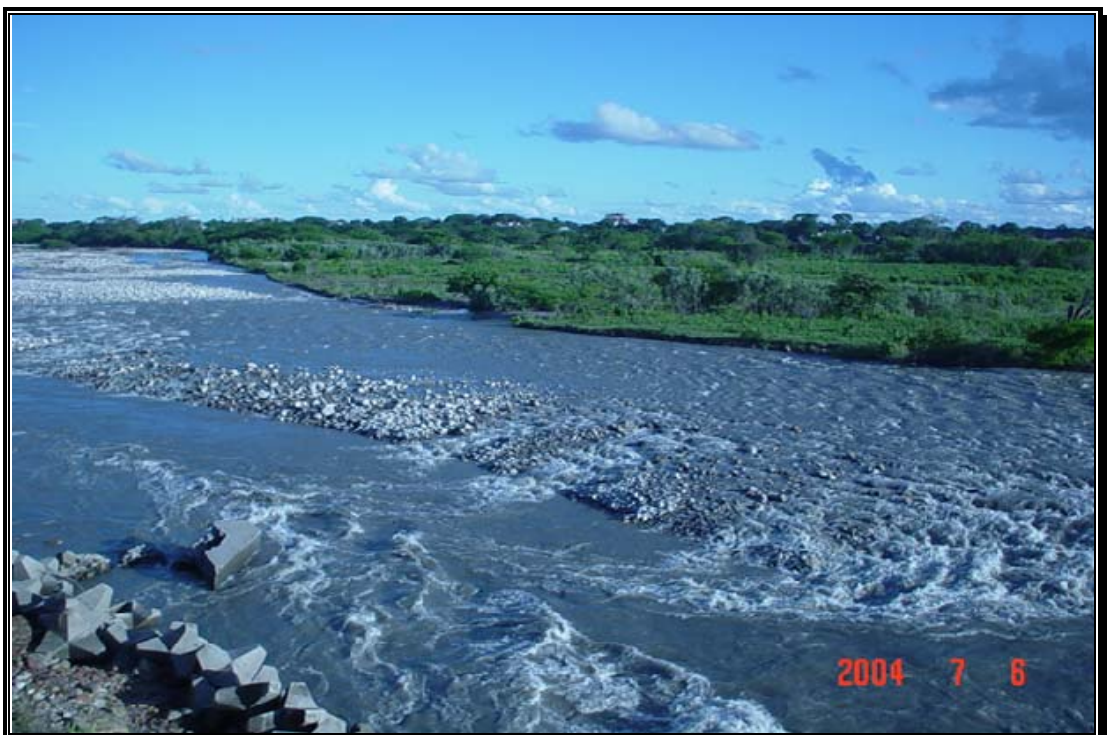
Fotografía 26. Flujo en gran parte concentrado hacia la base del talud de la margen izquierda junto al sitio crítico de la vía a Pore.
