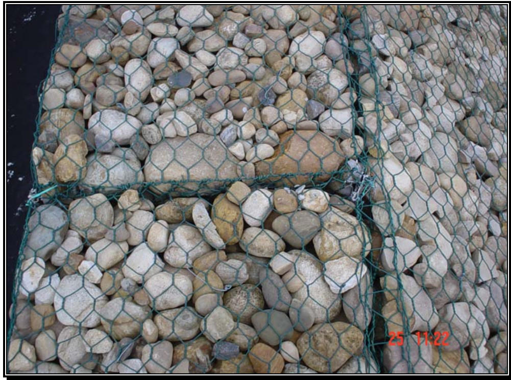
Fotografía 91. Forma de amarre de las cajas del colchón reno colocado sobre el dique de protección.
