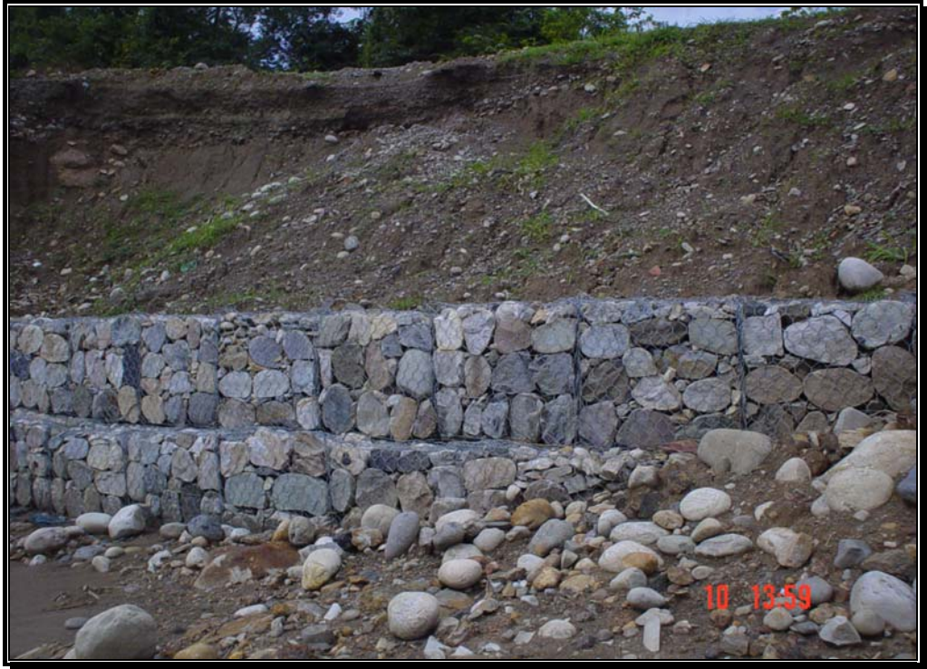
Fotografía 49. Gavión en malla con material de río sobre la margen izquierda para proteger la vía Yopal - Pore
