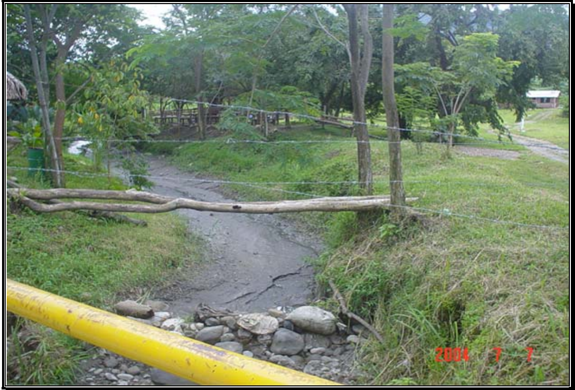
Fotografía 31. Intercepción del canal El Remanso con la vía a Siribana.
