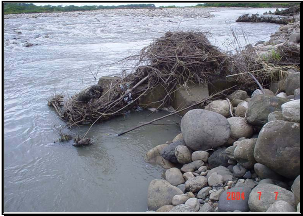
Fotografía 111. Hexápodos de gran tamaño colocados en la orilla derecha para proteger un sector cercano a la urbanización La Arboleda.
