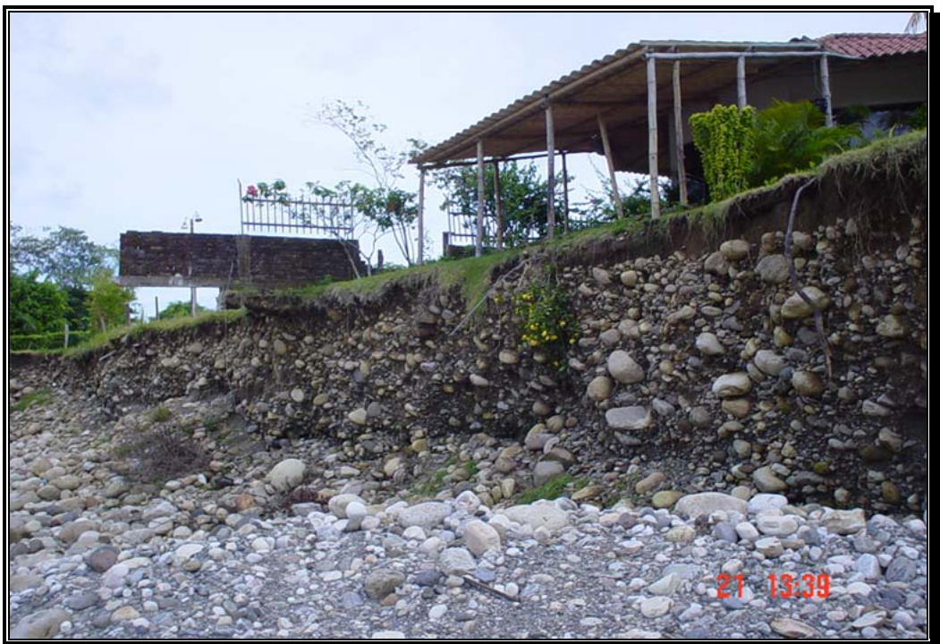
Fotografía 38. Talud de la urbanización La Casa del Río en Octubre de 2003.
