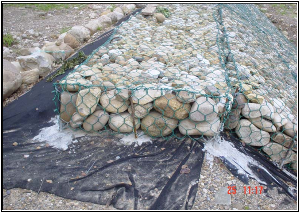
Fotografía 94. Geotextil bajo el colchón reno y sobre el dique.
