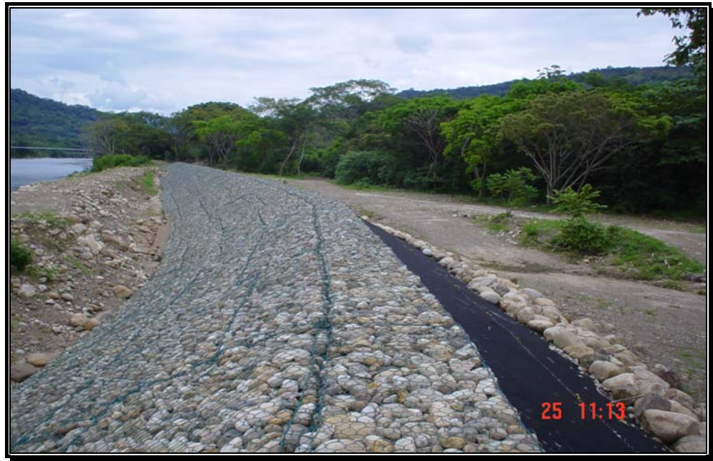
Fotografía 79. Dique para proteger el Parque La Iguana. Obra construida en Aguazul.
