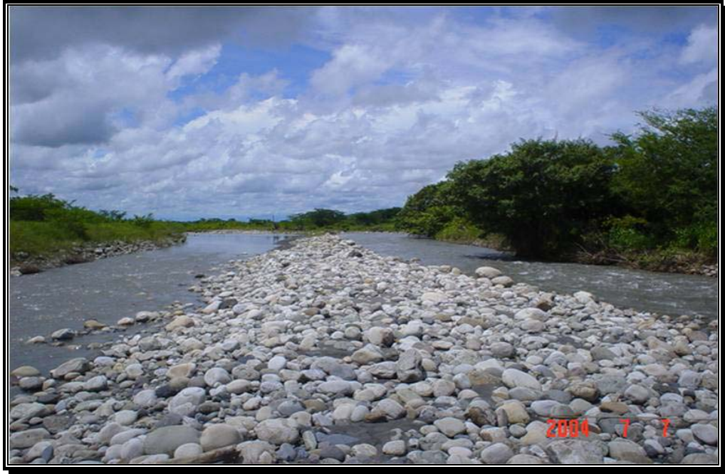
Fotografía 77. Jarillón con material del río para la entrada de agua al canal de Márquez.
