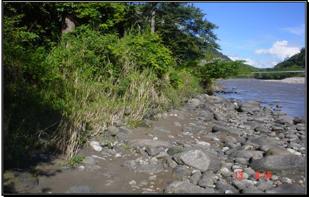
Fotografía 83. Punto de inicio de construcción del dique.
