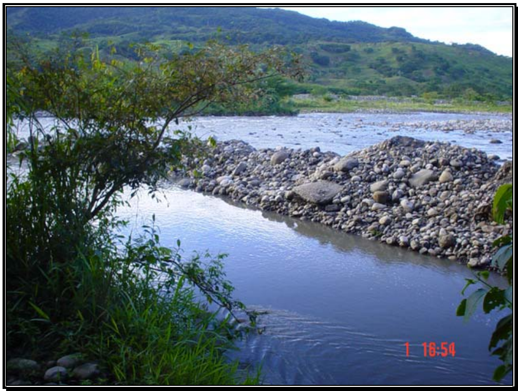
Fotografía 64. Jarillón y ancho del canal de entrada a la bocatoma de Matepantano.
