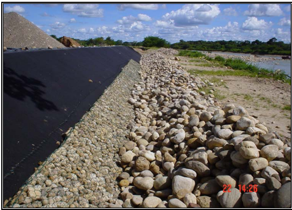
Fotografía 90. Material para rellenar el colchón reno, geotextil y su tejido.
