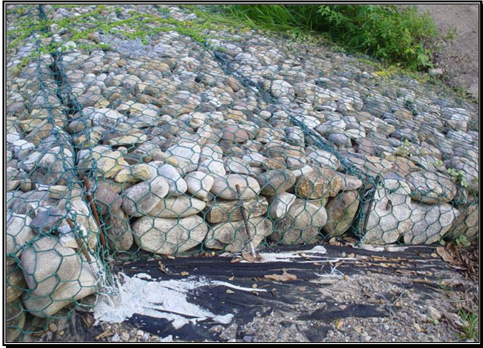
Fotografía 109. Anclajes metálicos para asegurar el colchón reno de la superficie del dique.
