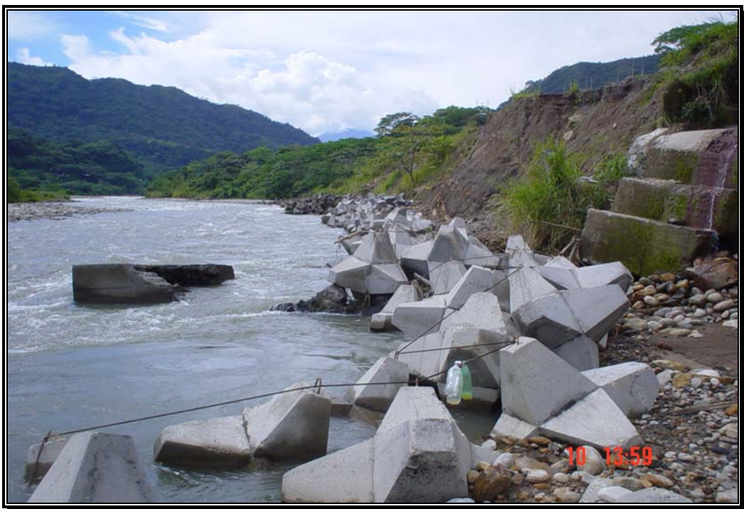
Fotografía 52. Hilera de hexápodos en la base del talud de la margen izquierda, entre la barra No. 1 y No. 2.
