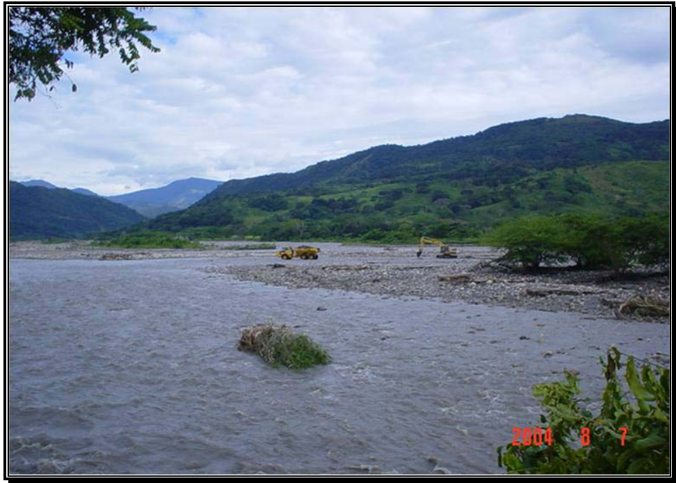
Fotografía 101. Excavación de material en el lecho del río para desviarlo hacia la parte central y quitar fuerza al caudal del brazo derecho.
