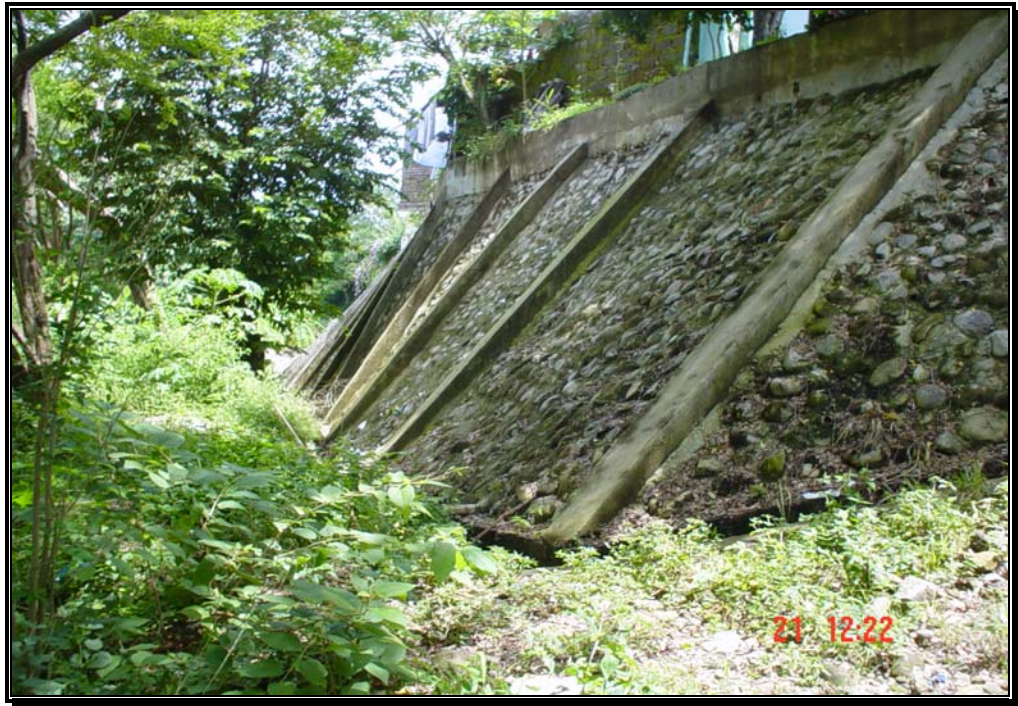
Fotografía 57. Protección del talud frente al parque de La Iguana en cemento y piedra.
