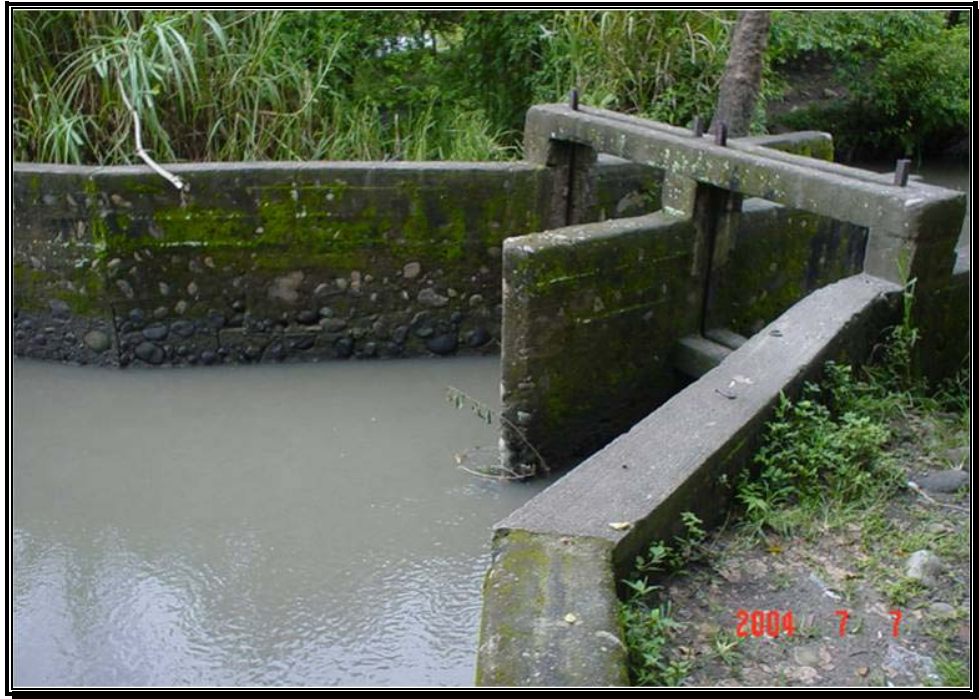
Fotografía 73. Estructura de control a la entrada del canal de Matepantano.
