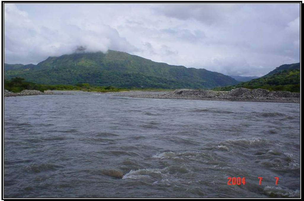
Fotografía 71. Restos de un dique con material suelto construido en una barra cerca al canal El Remanso.
