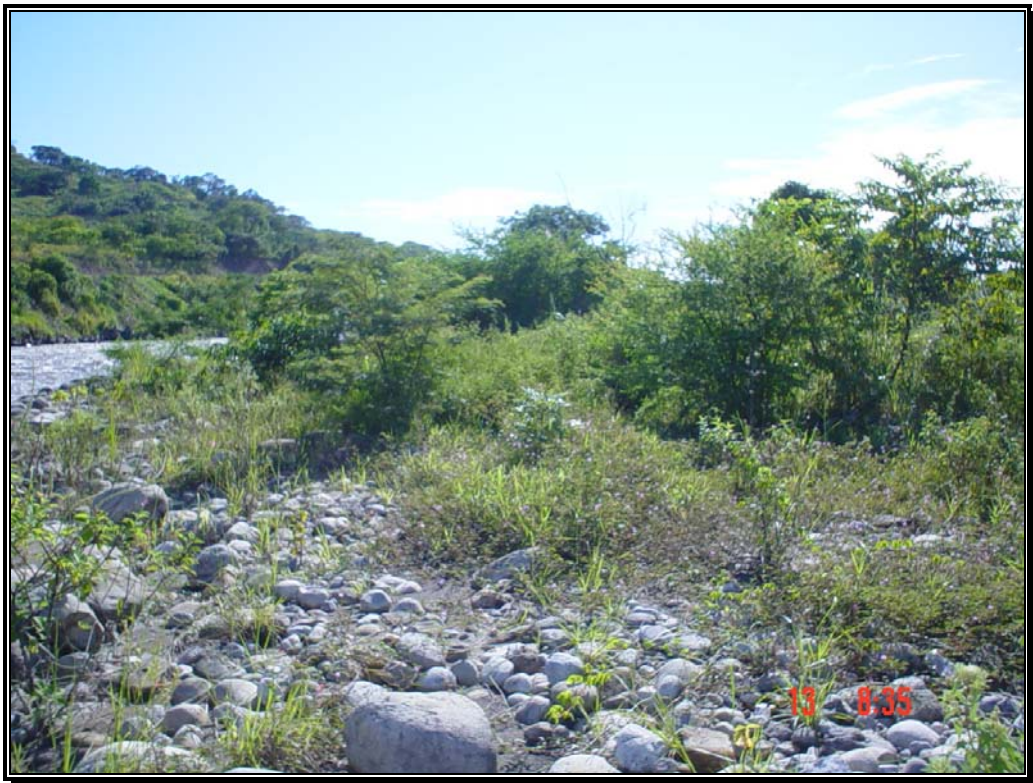
Fotografía 84. Punto final de construcción del dique.
