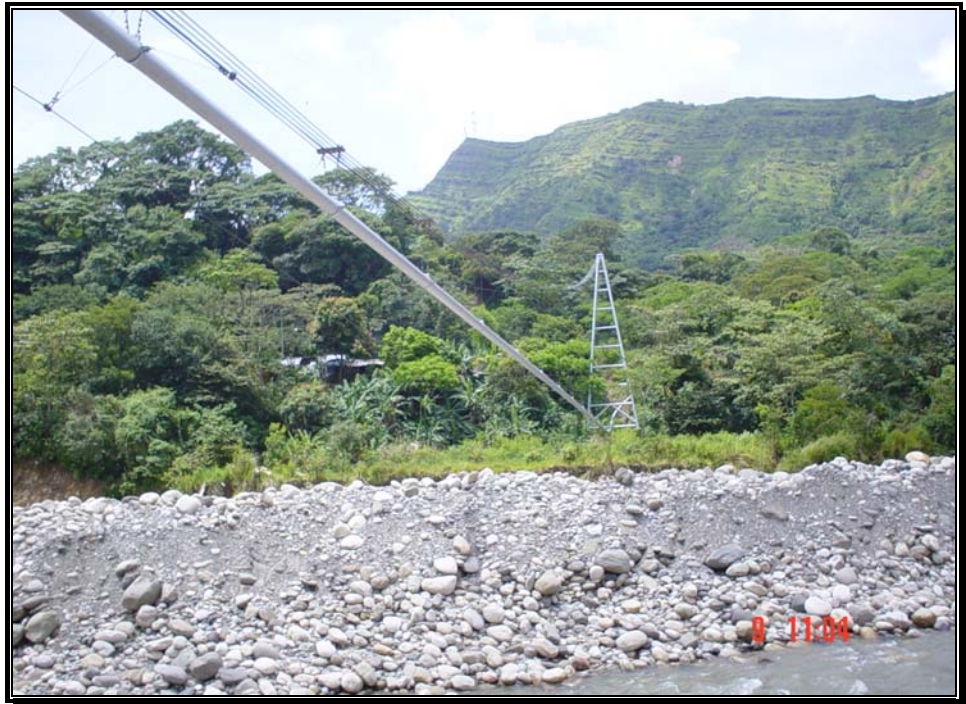
Fotografía 23. Barra artificial con material del lecho y acumulada en la parte central entre el oleoducto de Perenco y la barra de La Iguana.
