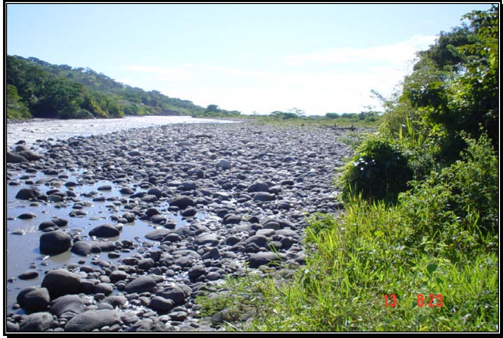
Fotografía 85. Tramo de la barra del parque La Iguana donde se pretende construir el dique de protección.
