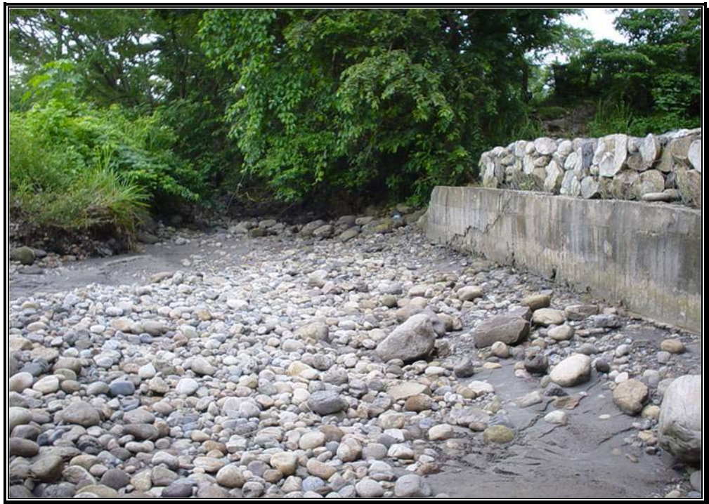
Fotografía 104. Lugar de construcción de las compuertas para el sistema canales.
