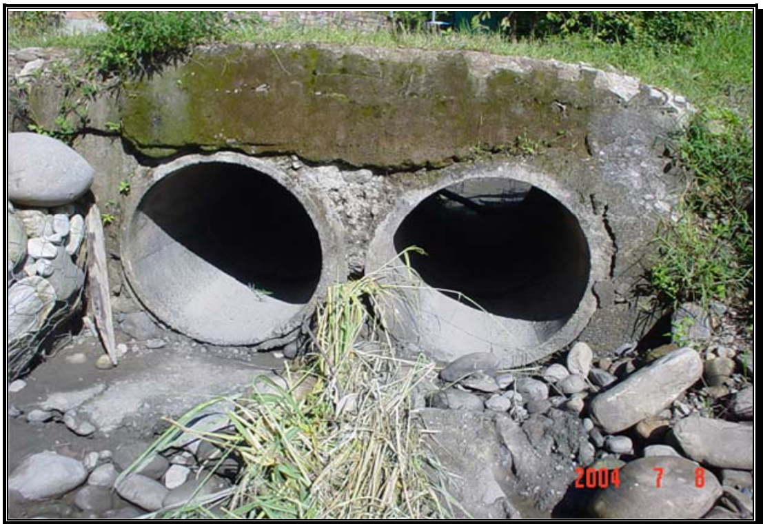
Fotografía 30. Estructuras en el canal El Remanso: alcantarilla circular.
