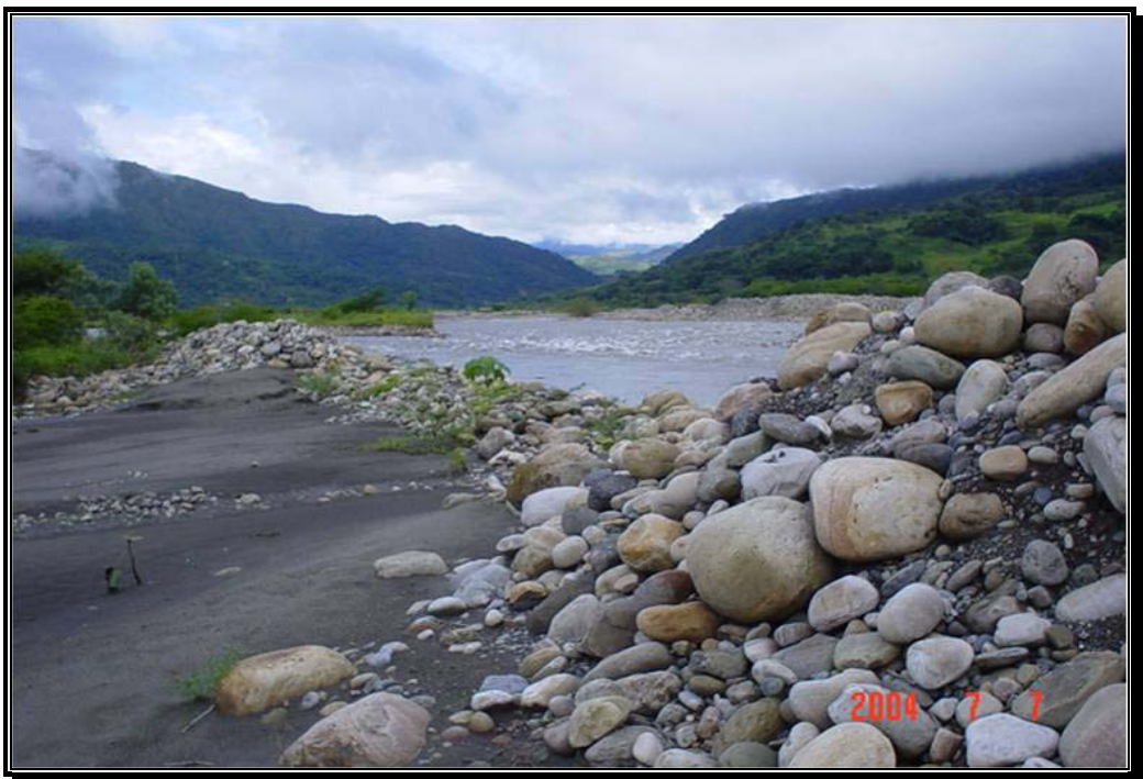
Fotografía 72. Diques con material del río aguas arriba de la urbanización La Casa del Río, colocado sobre la barra No. 3
