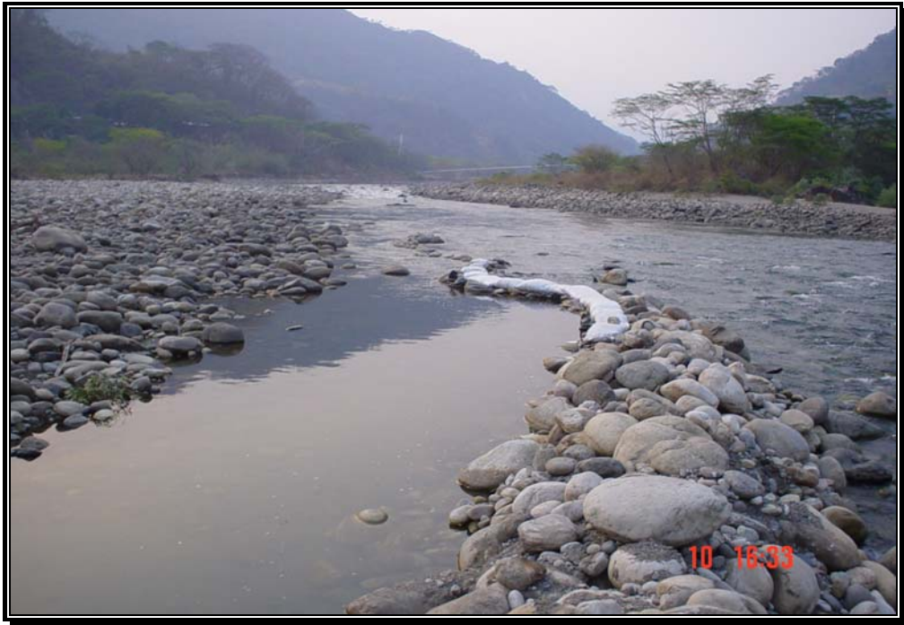
Fotografía 86. Canal y bocatoma de entrada de agua al parque La Iguana. Sitio donde se construirá un pontón bajo el dique.
