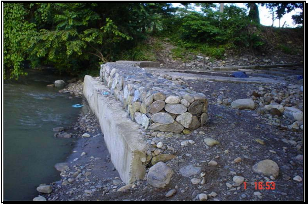
Fotografía 67. Gavión para proteger la entrada al canal de riego de El Remanso- margen derecha del talud del río Cravo Sur.
