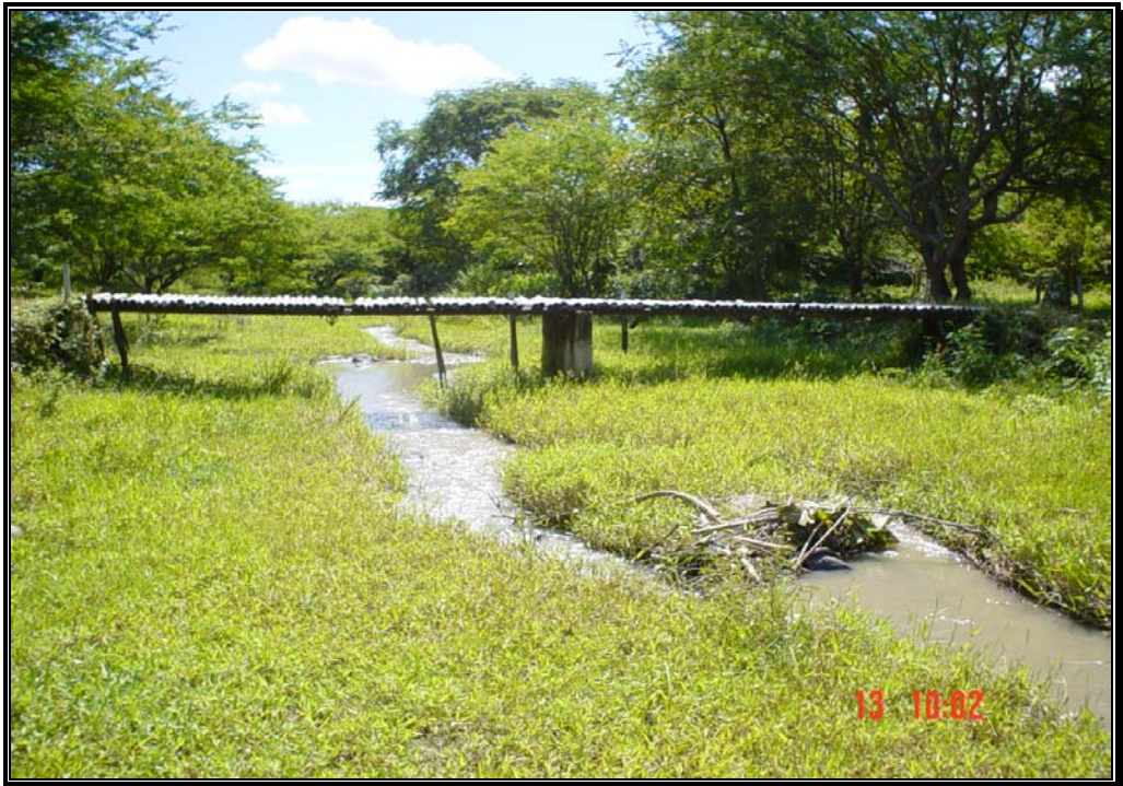
Fotografía 12. Talud en la barra del Parque La Iguana y Caño 2 Río Cravo Sur
