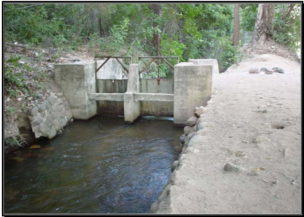
Fotografía 74. Tipo de compuertas utilizadas la cual se encuentra en el canal de Márquez.
