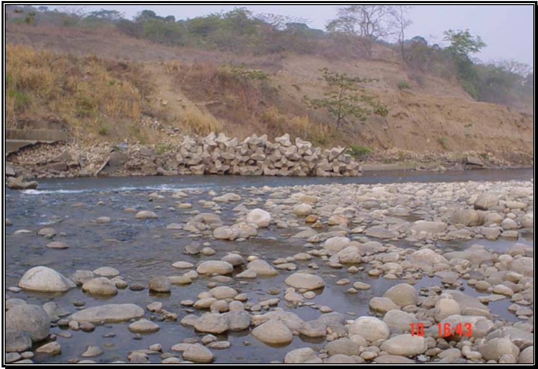
Fotografía 51. Espolones con hexápodos en la base del talud de la margen izquierda, frente a la barra No. 1.
