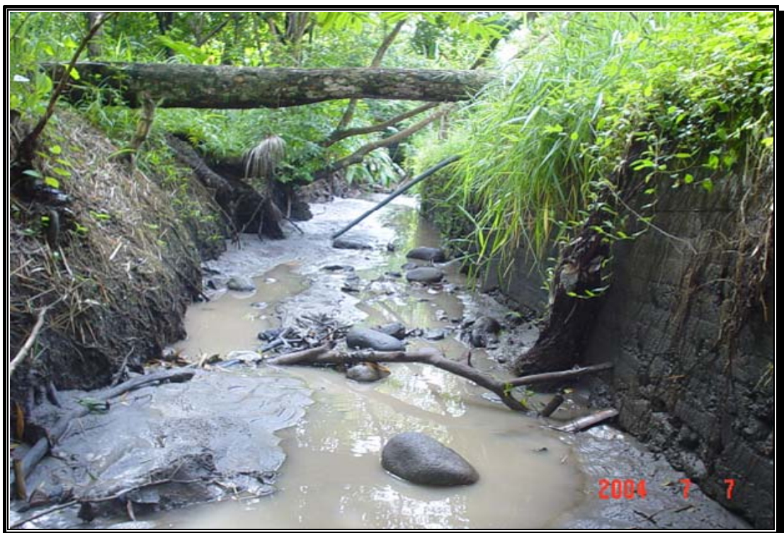
Fotografía 28. Canal El Remanso con un muro en concreto para la protección en su talud.
