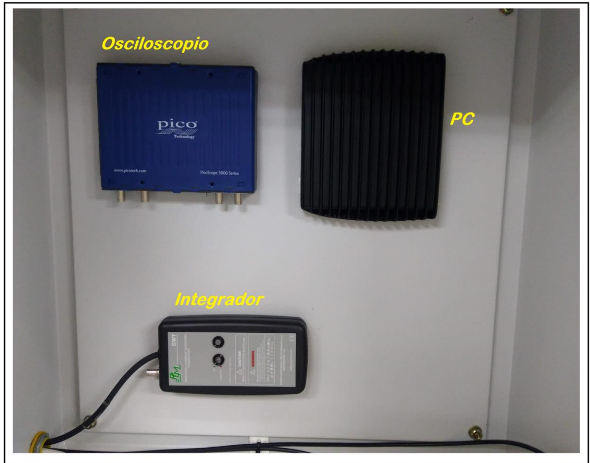
FIGURA 16: Fijado de equipos en el cofre de intemperie
