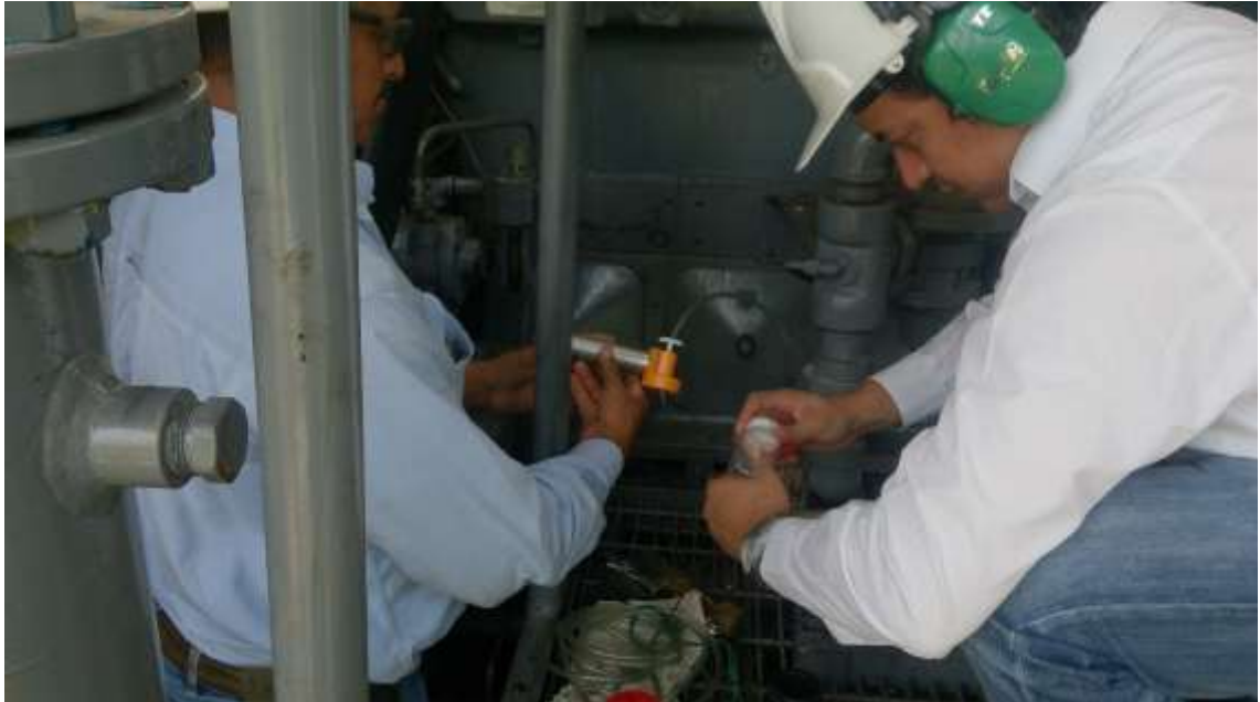
Figura 84. Toma de muestra de aceite desde el carter a través de un “vampiro” de succión
