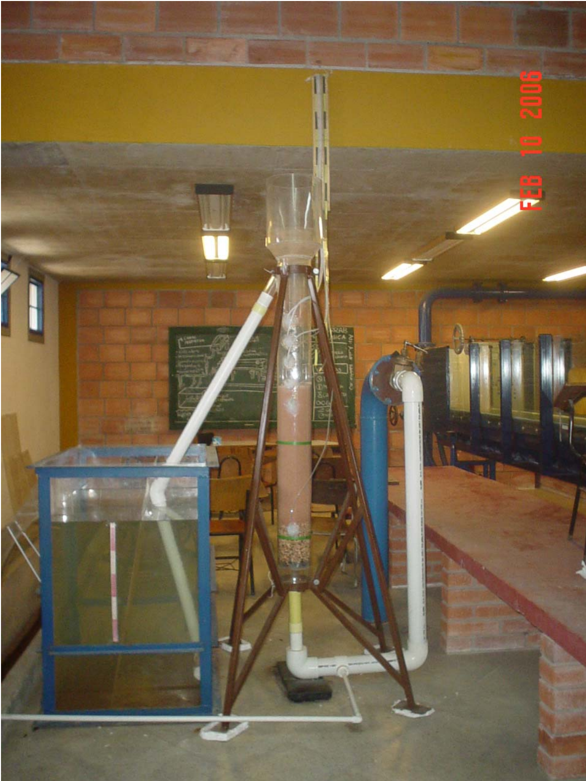
Foto 1. Sistema hidráulico del filtro
