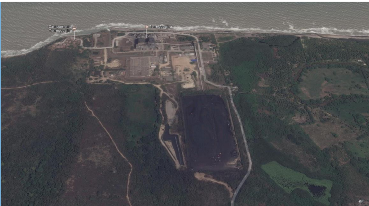
Figura 4. Vista aérea de la Central Termoguajira
