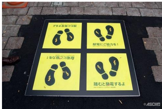
Figura 3. Baldosa piezoeléctrica utilizada en Japón.
