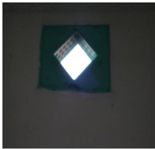
Ventana con malla
