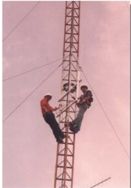
Foto No. 2. Montaje del anclaje que permitirá cabecear la antena.
