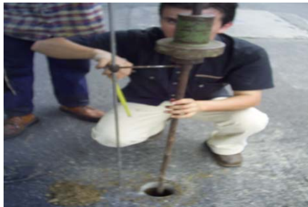
Figura 3. 19 Ensayo de cono dinámico y medición de penetración vertical.
