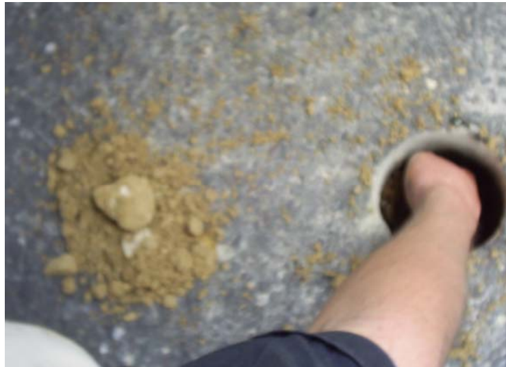
Figura 3. 14 Extracción del material de base de la calzada S-N.
