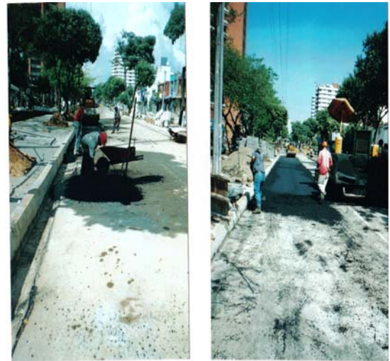
Figura 2. 8 Bacheo y aplicación del refuerzo calzada N-S
