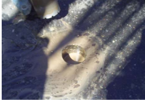
Figura 3. 12 Detalle del espesor de carpeta de rodadura utilizada en la calzada N-S.
