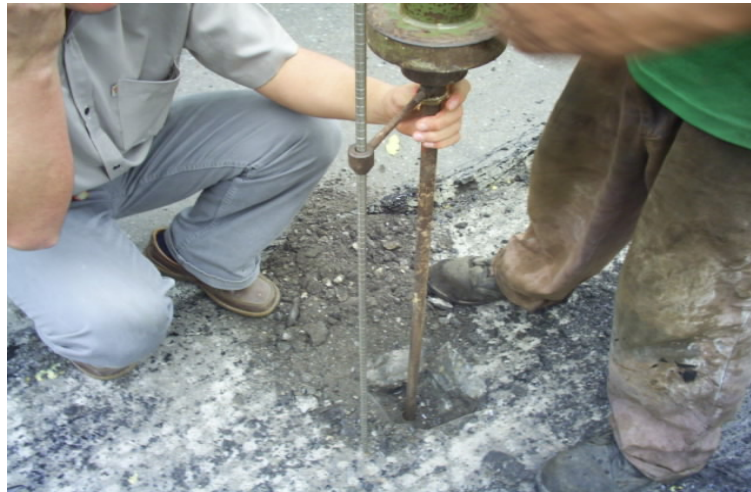
Figura 3. 18 Fotos tomadas durante la ejecución del ensayo de cono dinámico en cada calzada.
