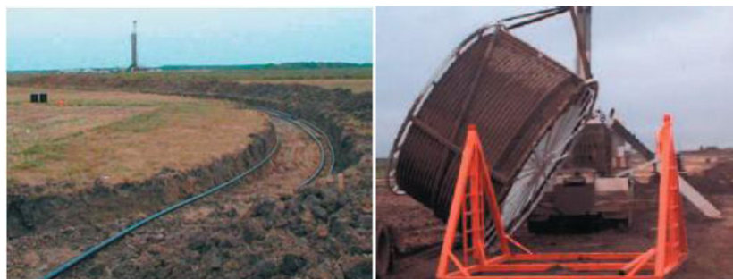
Figura 8. Instalación Tubería Fibra de Vidrio
