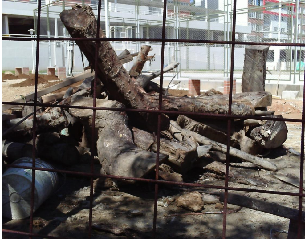
Foto 4. Material que impide el paso del flujo de aguas lluvias.
