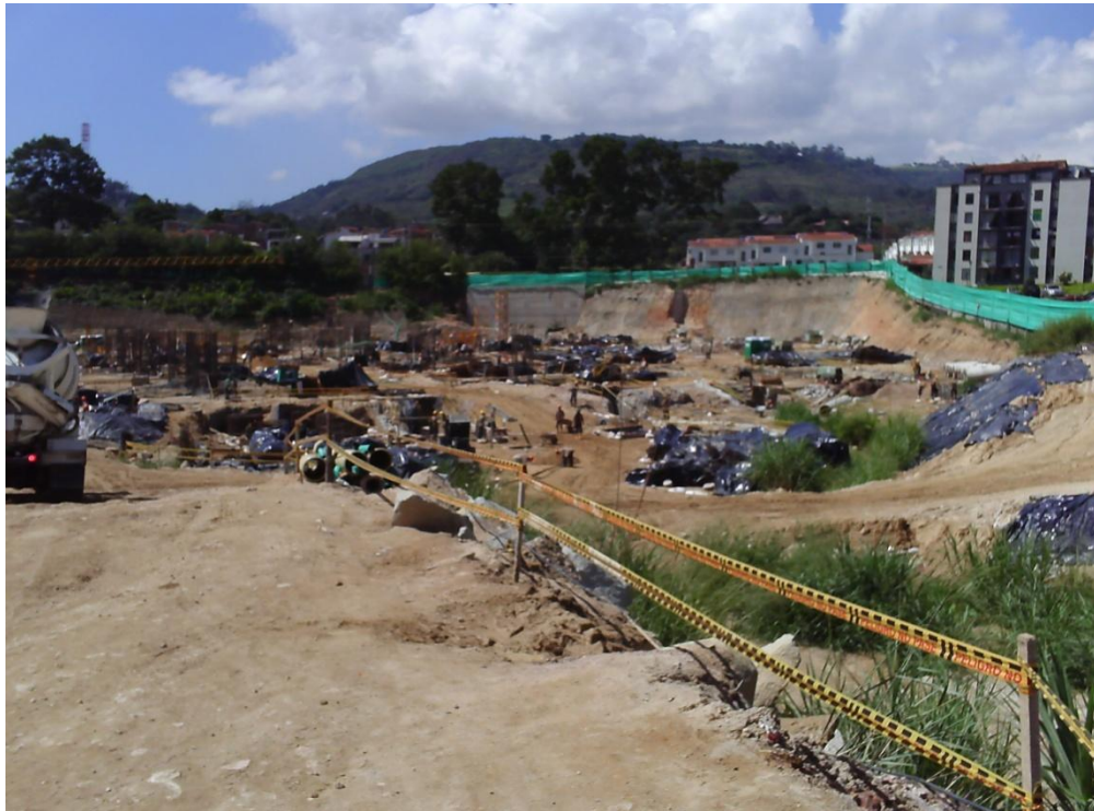
Foto 1. Estación de Metrolínea Cabecera.
