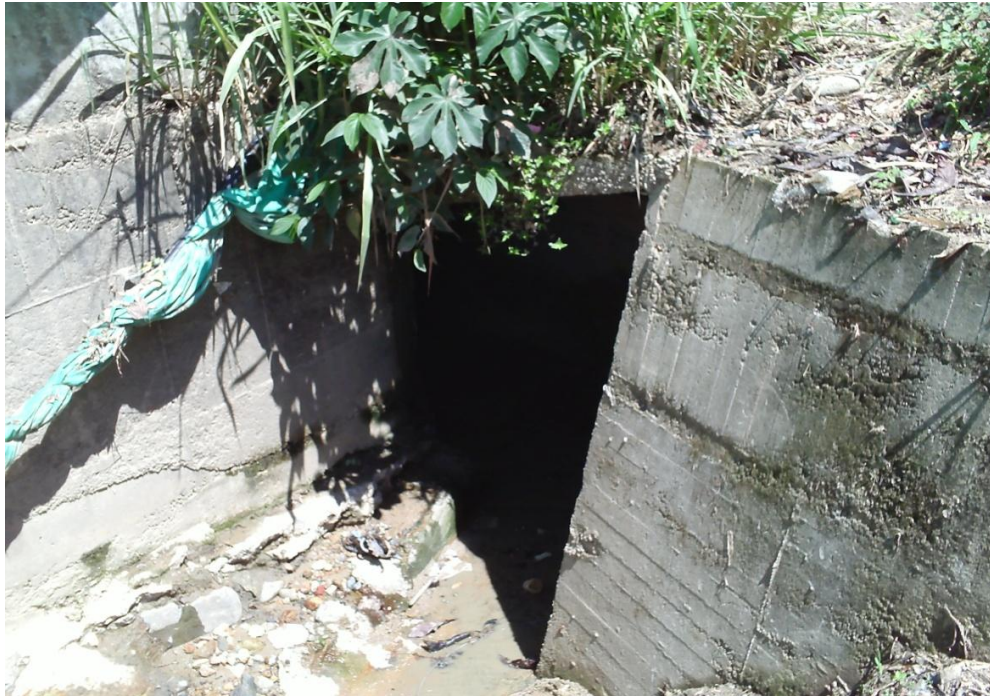
Foto 3. Entrada al box-couvert.
