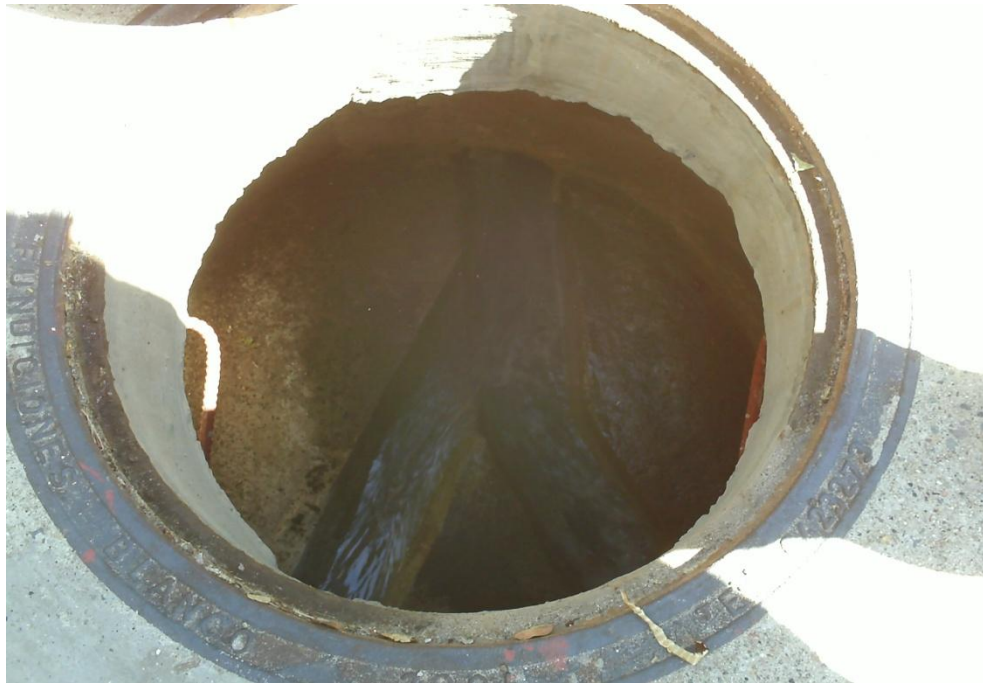
Foto 5. Pozo exterior, reposición de tubería.
