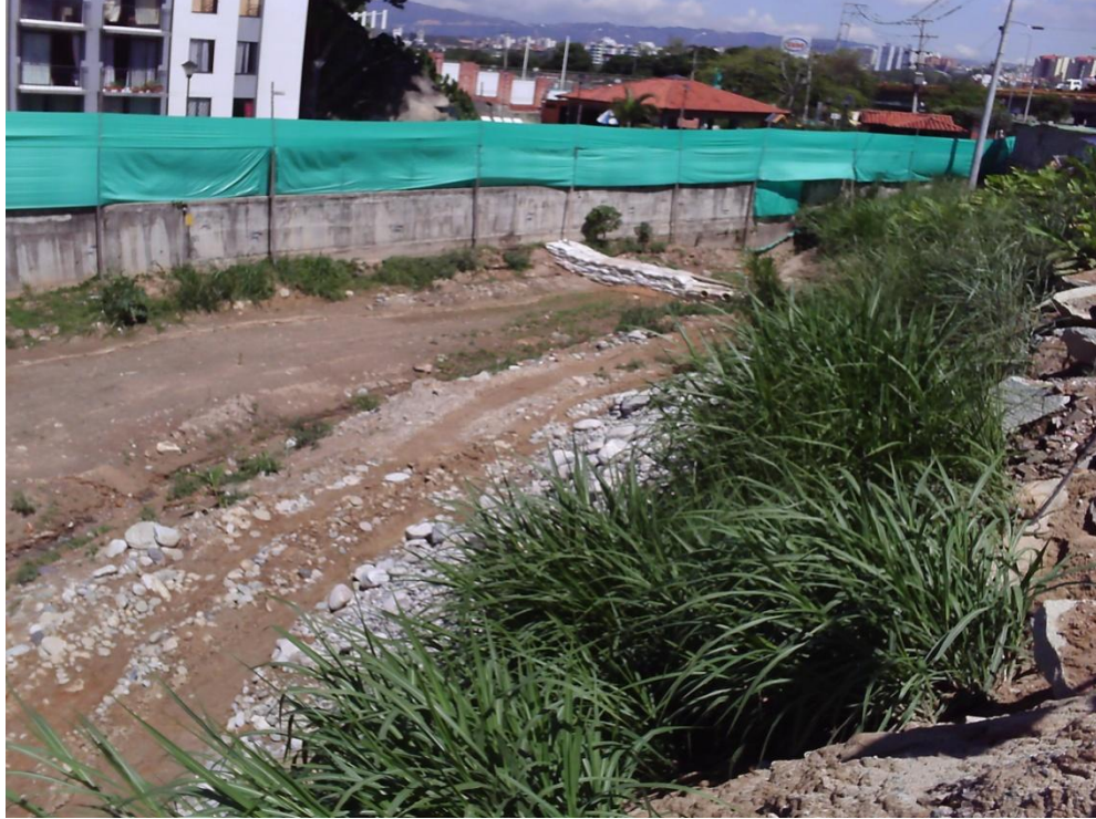
Foto 2. Estación de Metrolínea Cabecera.
