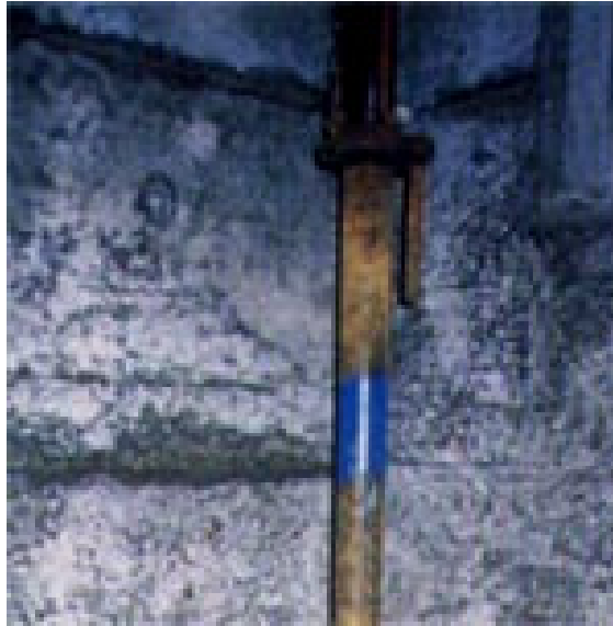
Foto 22. Superficie poco estética resultante de la microsegregación entre los agregados finos y la pasta de cemento
