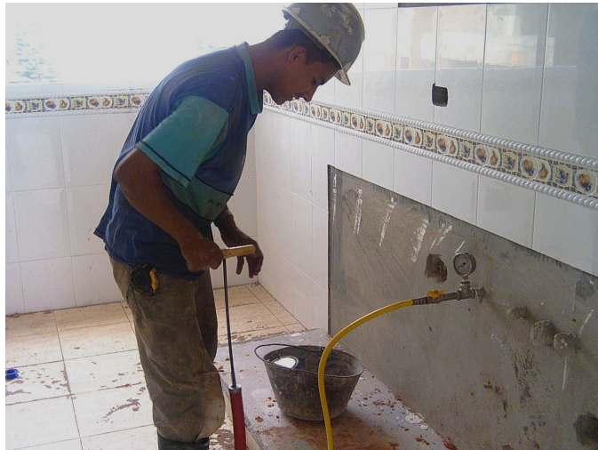
Foto 2 Pruebas de presión en tuberías
