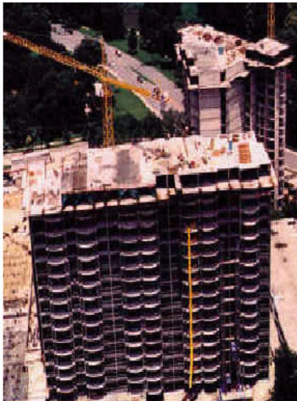
Foto 6. Sistema constructivo túnel
