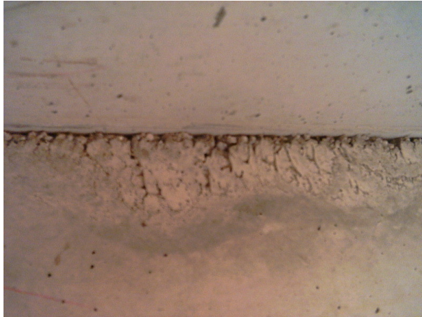
Foto 26. Hormigoneado del concreto
