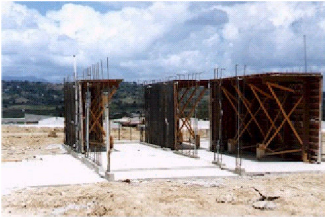
Foto 13. Colocación de refuerzo y formaleta de muros
