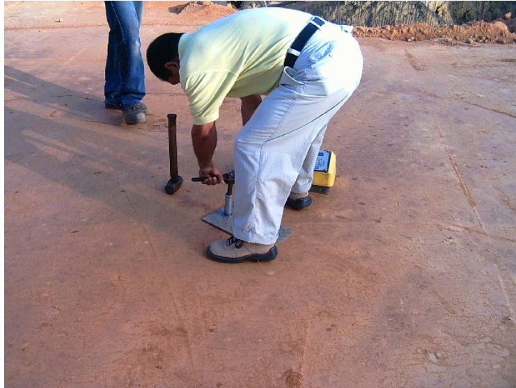
Foto 5 Densidad en rellenos
