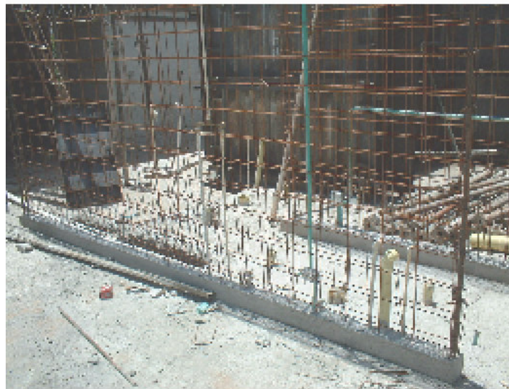
Foto 12. Amarre de mallas en muros.
