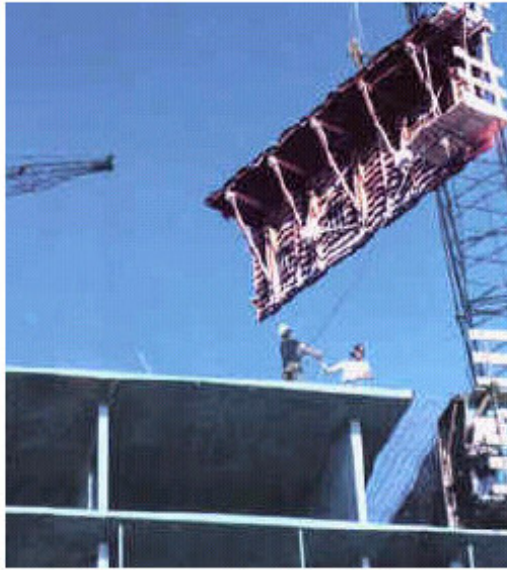
Foto 16. Traslado de formaleta semitunel
