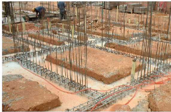
Foto 9. Amarre de cimentación a muros
