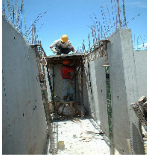
Foto 14. Continuidad en muros
