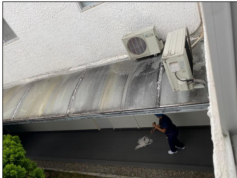
Figura 10 Estado Actual Cubierta En Policarbonato
