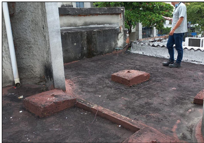
Figura 12 Estado Actual Cubierta Principal
