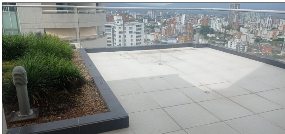
Figura 3 Registro Fotográfico Piso 20
