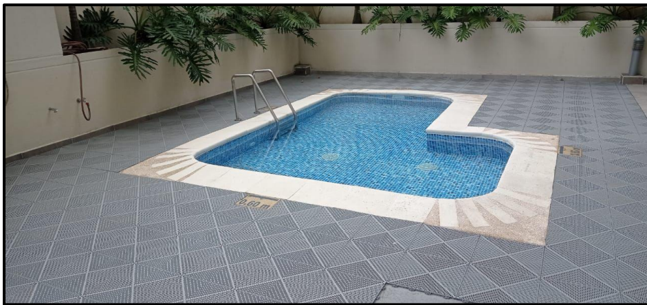
Figura 2 Registro Fotográfico Piso 6
