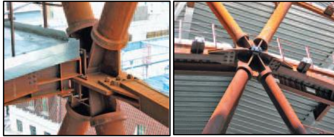
Figura 10. Nodo entre la placa soportada en el núcleo, y el exoesqueleto de un sistema Diagrid
