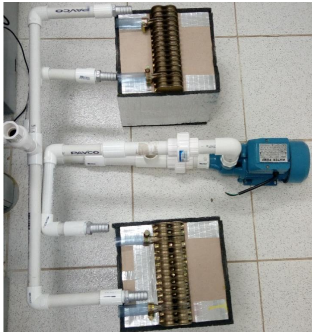
Figura 42. Montaje de intercambiadores de calor acoplados.
