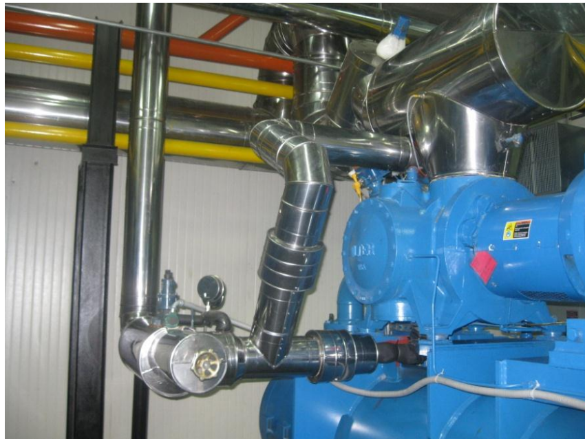
Figura 22. Puerto de succión lateral
