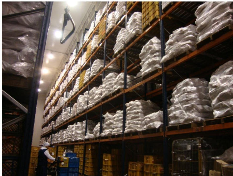
Figura 64. Interior de la cámara de conservación
