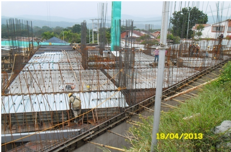
Ilustración 5. Armado Placa Steel Deck Sot. 1 Trr 1. Fuente. El Autor.
