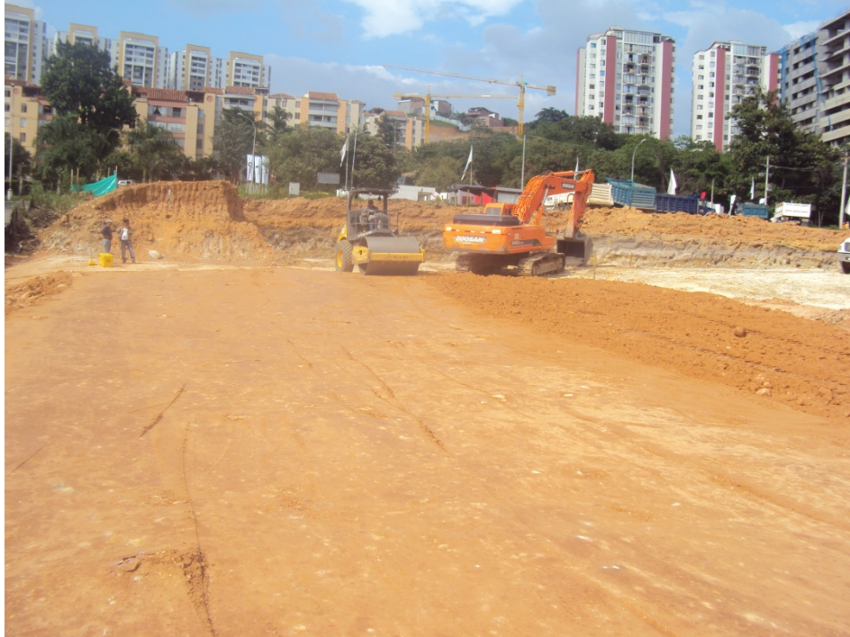
Ilustración 3. Recompactación de una capa de relleno. Fuente. El Autor.
