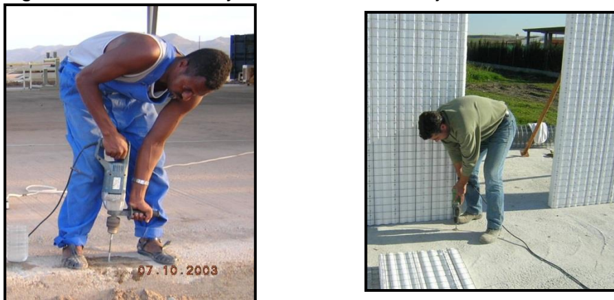
Figura 19. Perforación y colocación de anclajes
