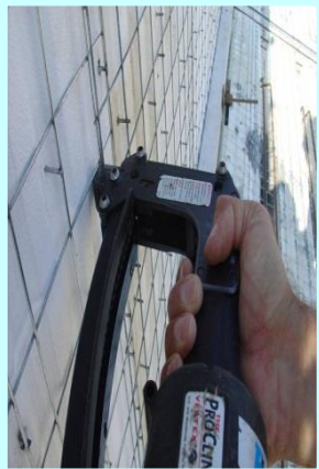
Figura 23. Unión de paneles
