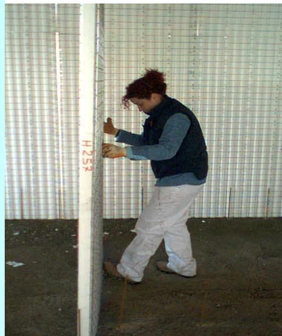
Figura 21. Montaje y nivelación
