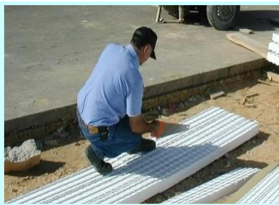
Figura 22. Corte de paneles
