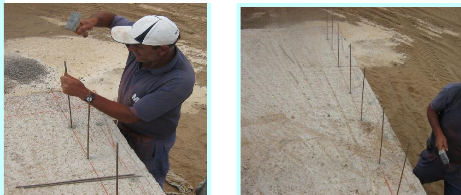
Figura 20. Colocación de anclajes
