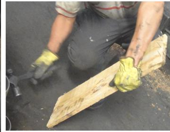
Retiro de las puntillas
