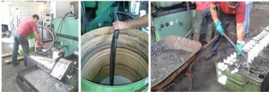
Figura 79. Procedimiento para la limpieza de los tanques
