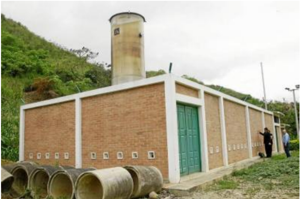
Figura 16. Planta desgasificadora implementada por BIONERSIS. 102
