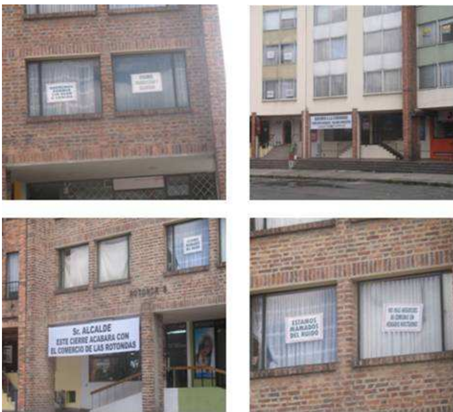
Figura 51. Conflicto de usos de suelo en edificaciones.
