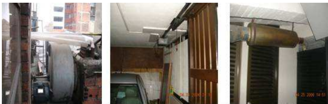
Figura 49. Contaminación sonora proveniente sistemas hidromecánicos, plantas eléctricas, sistemas de ventilación, sistemas de apertura de puertas en garajes y parqueaderos, entre otros.
