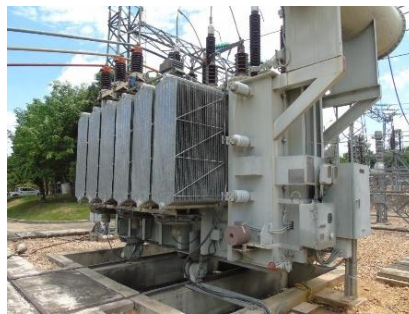
Figura 3. Transformador sub. Palenque
