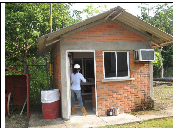
Figura 13. Fachada Laboratorio C.P Fuente: El Autor
