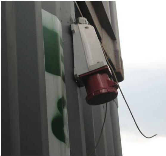
Figura 52. Punto de conexión de energía al container
