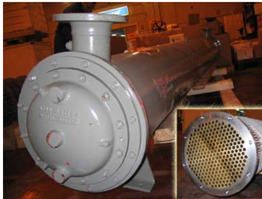
Figura 12. Condensador de coraza y tubos.
