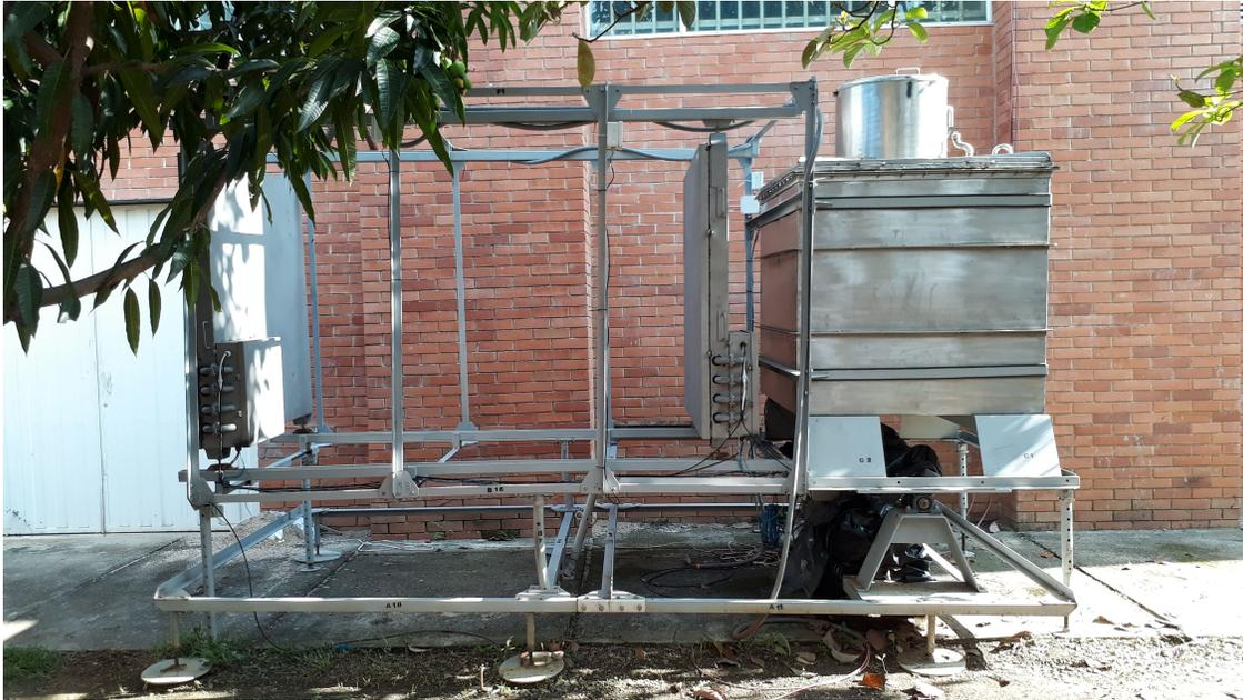
*Figura 129.* Instalación del WCD en la estructura de MuTe. El WCD se sujeta a la estructura mediante dos abrazaderas metálicas con una capa interna de caucho y reposa sobre el pivote de inclinación con el fin disminuir el esfuerzo en el proceso de elevación de la estructura.
