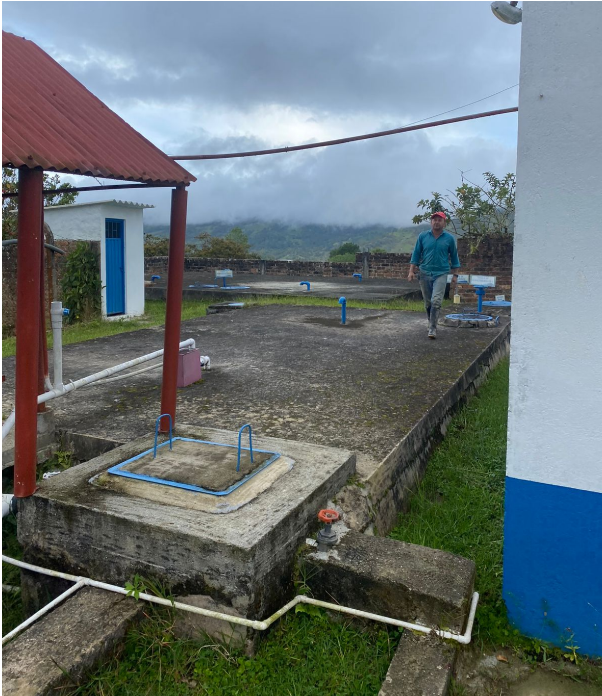
Fuente: Evidencia Fotografía tomada en una de las visitas al acueducto
