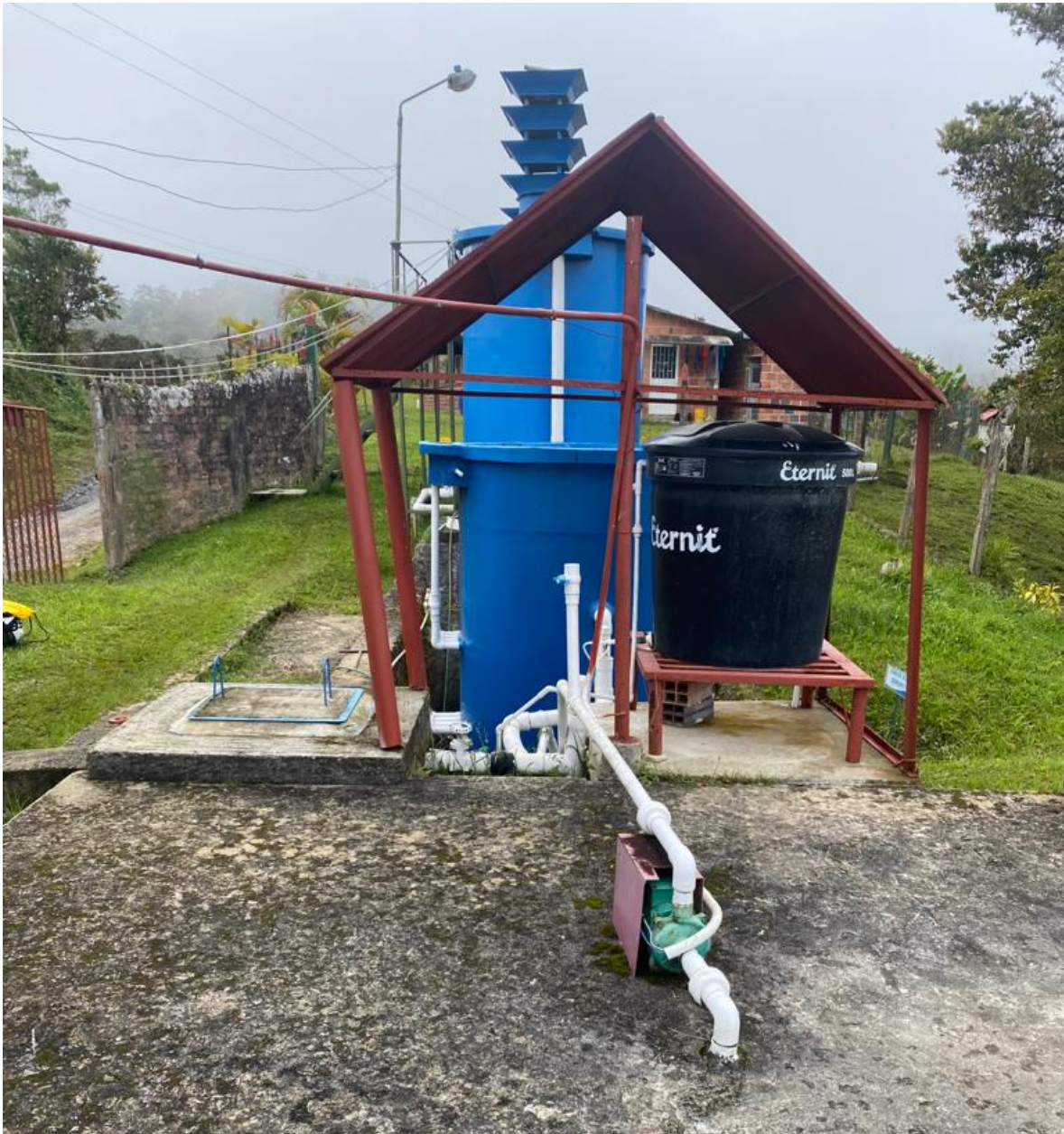
Fuente: Evidencia Fotografía tomada en una de las visitas al acueducto.
