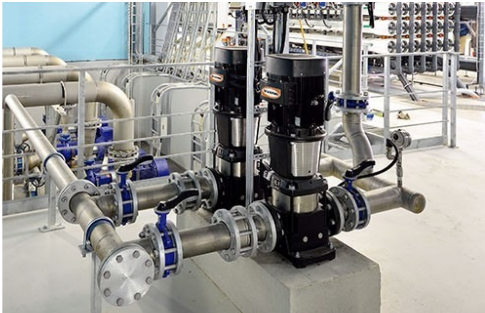
Figura 42 Ilustración montaje electrobombas alternadas de superficie.
