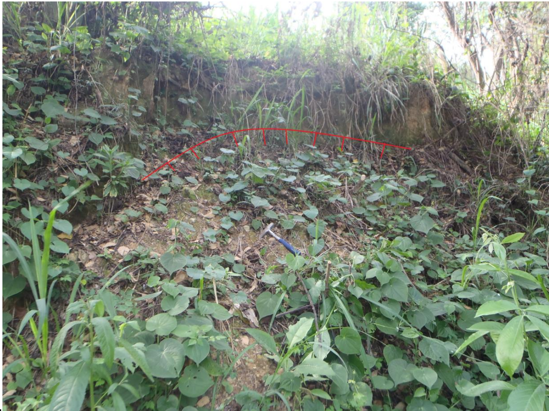
Figura 8. Suelo de coluvión activo, cubierto parcialmente por vegetación, en la parte alta se observa la corona, tomada hacia el suroeste
