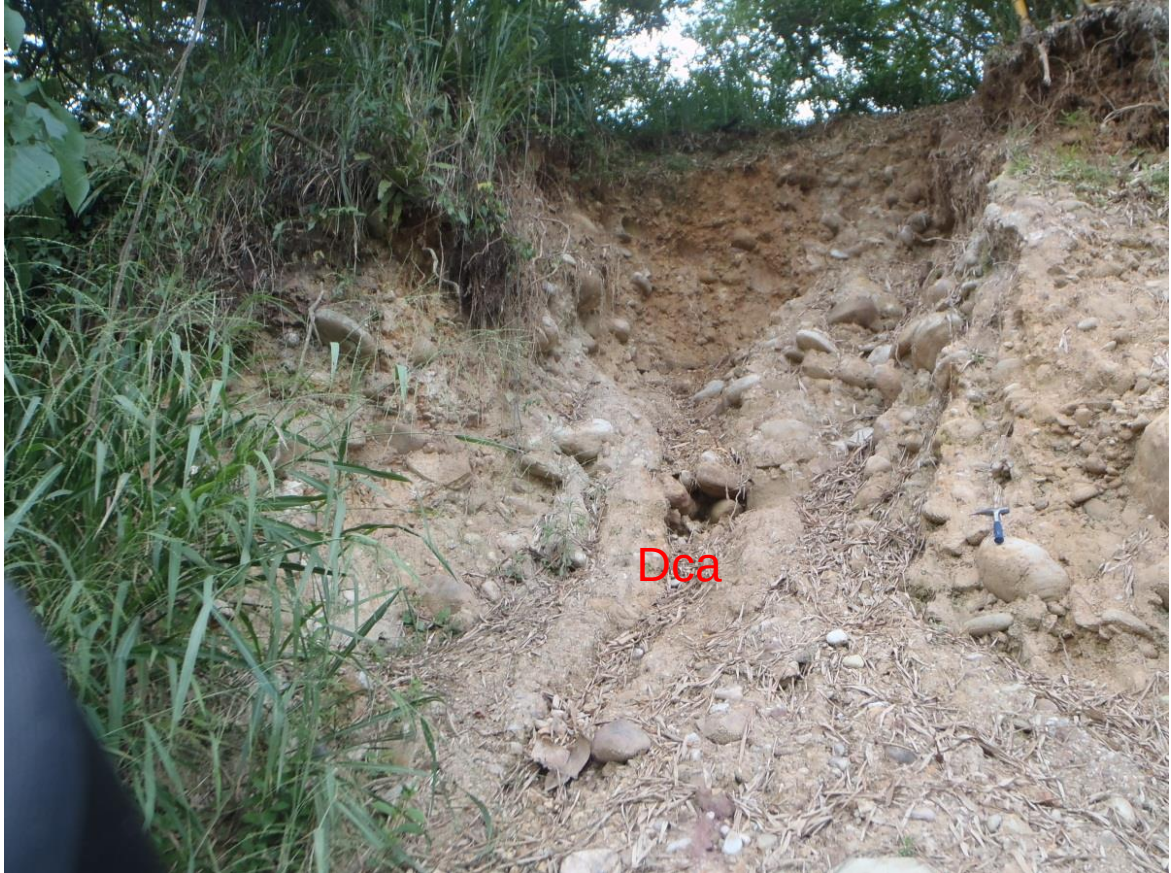
Figura 13. Coluvión activo (Dca) localizado en la ladera norte del valle, deposito matriz soportado con presencia de gravas y cantos subredondeados y subangulares, tomada hacia el norte.
