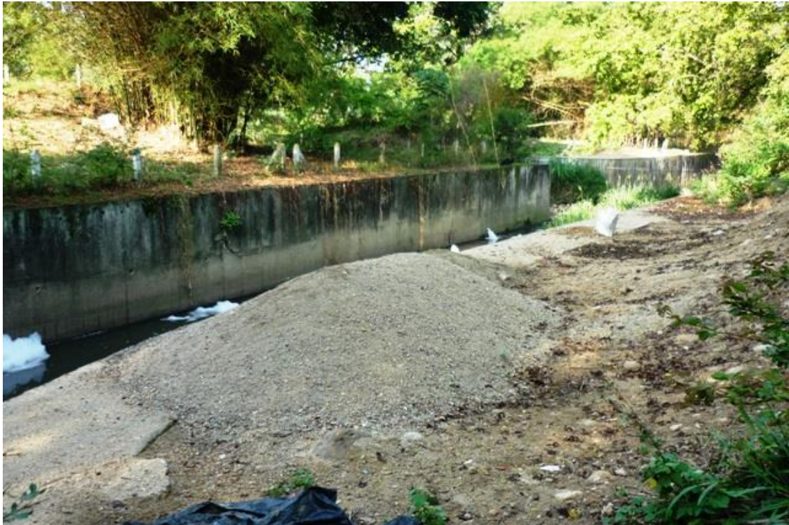
Figura 6. Se muestra el cauce actual de la quebrada el cual esta canalizado por muros de concreto, tomada hacia el NE.
