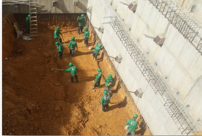
Figura 8. Visitas iniciales a la obra Agosto 4 de 2015
