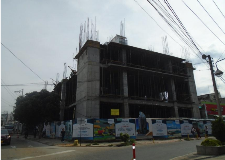
Figura 12. Estado actual de la obra Mayo 16 de 2016
