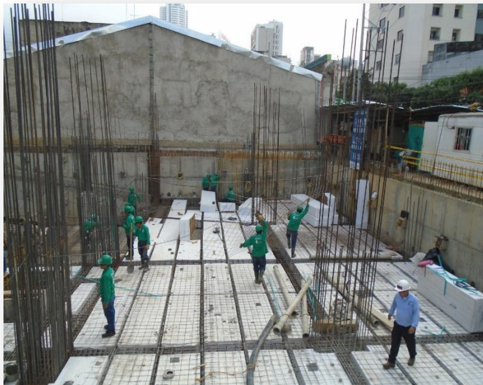
Figura 9. Placa sótano 1 costado sur Diciembre 1 de 2015
