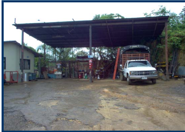
Figura 5. Sección de almacenamiento de productos químicos.
