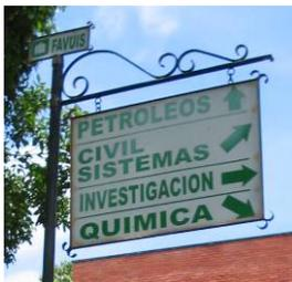
La estructura es metálica, con una columna de tubo cold rol de 2 pulgadas y marco de lámina del mismo material con arabescos en su parte superior y, en ocasiones, en las esquinas de los paneles.
