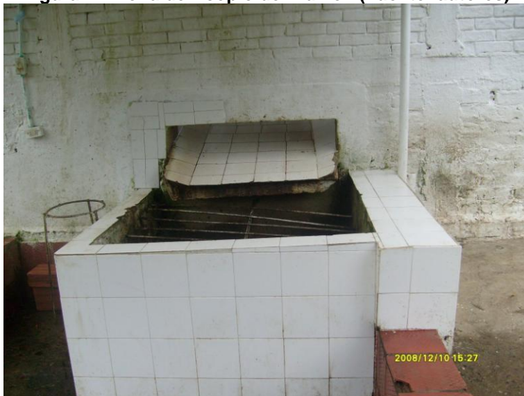
Figura 12. Zona de Acopio del Rumen (Fuente: autores)
