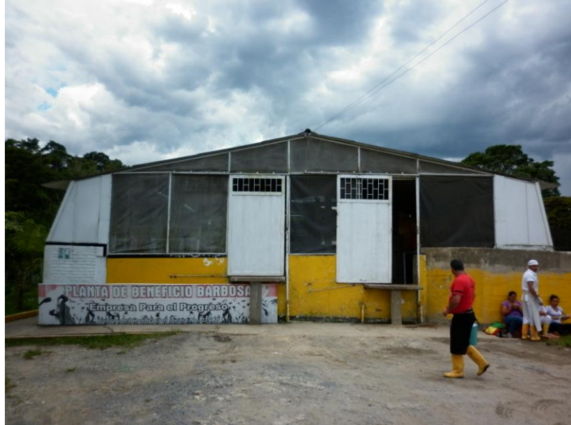
Figura 1. Planta de Beneficio del Municipio de Barbosa (Fuente: Autores)
