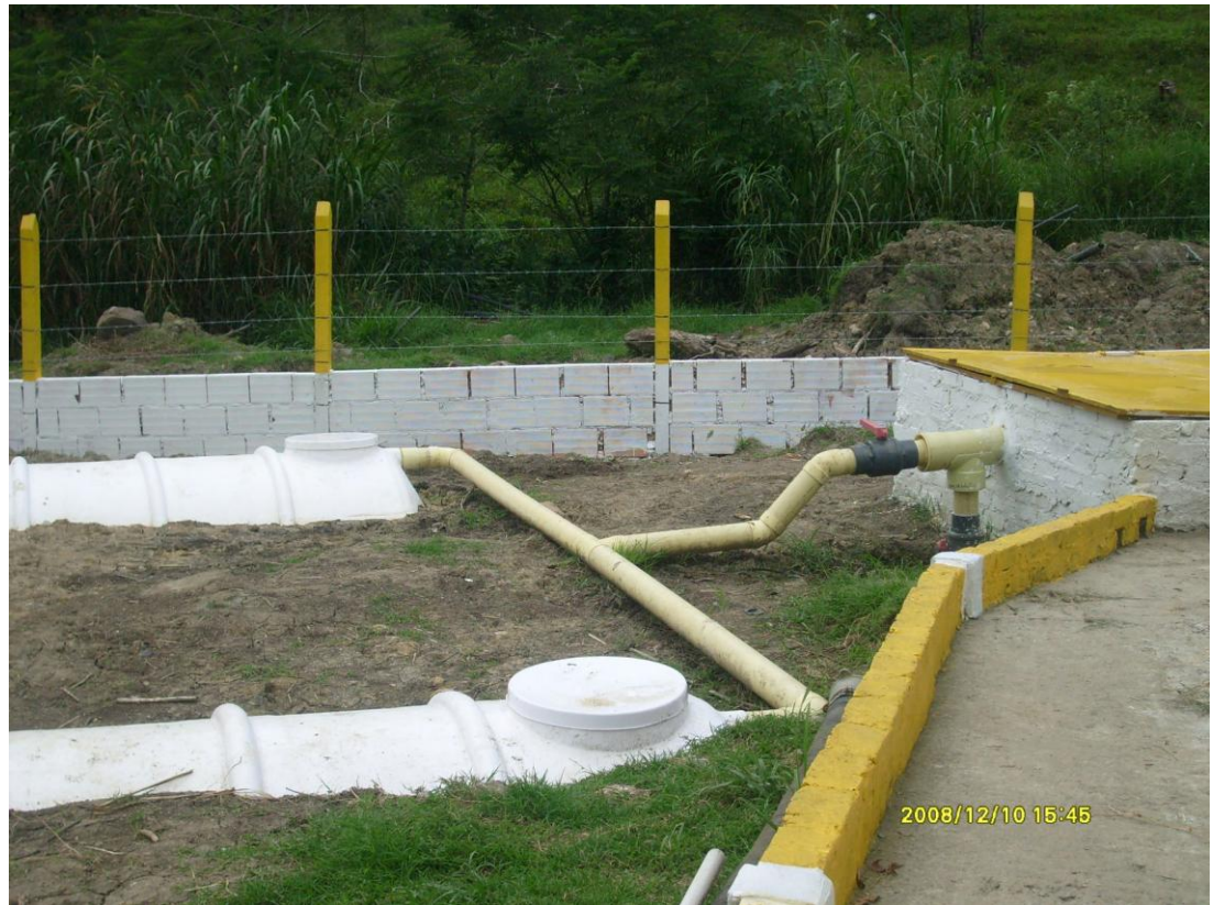
Figura 11. Reactores Anaerobios (Fuente: Autores)
