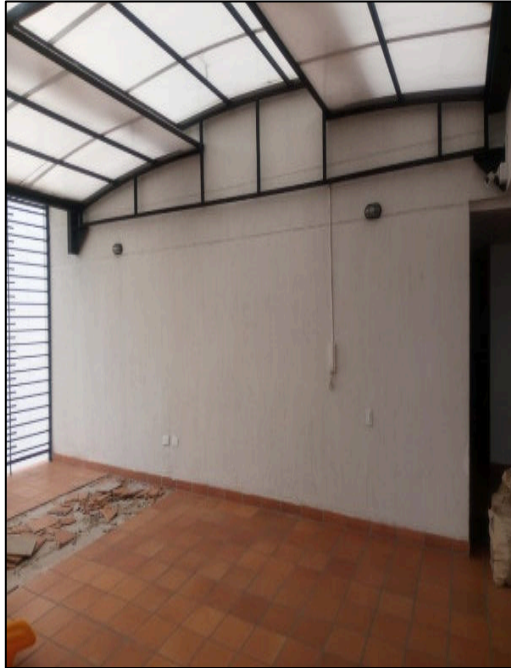
Figura 11. Registro fotográfico tomado durante la visita de reconocimiento hecha al edificio Palladio
