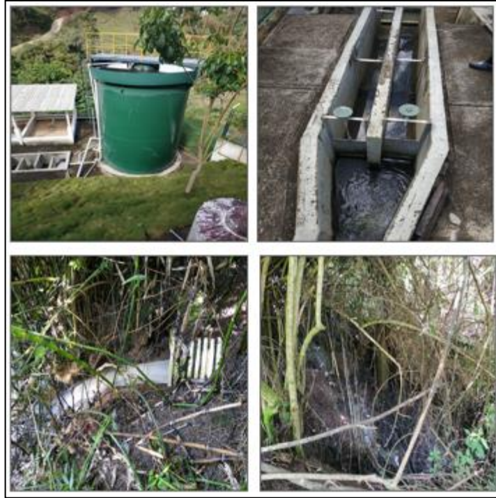
Figura 11. Evidencia Fotográfica visita PTAR CALIFORNIA
