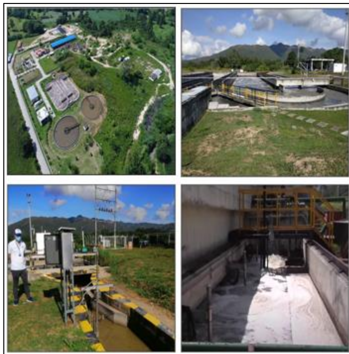
Figura 8. Evidencia fotográfica PTAR El Santuario
