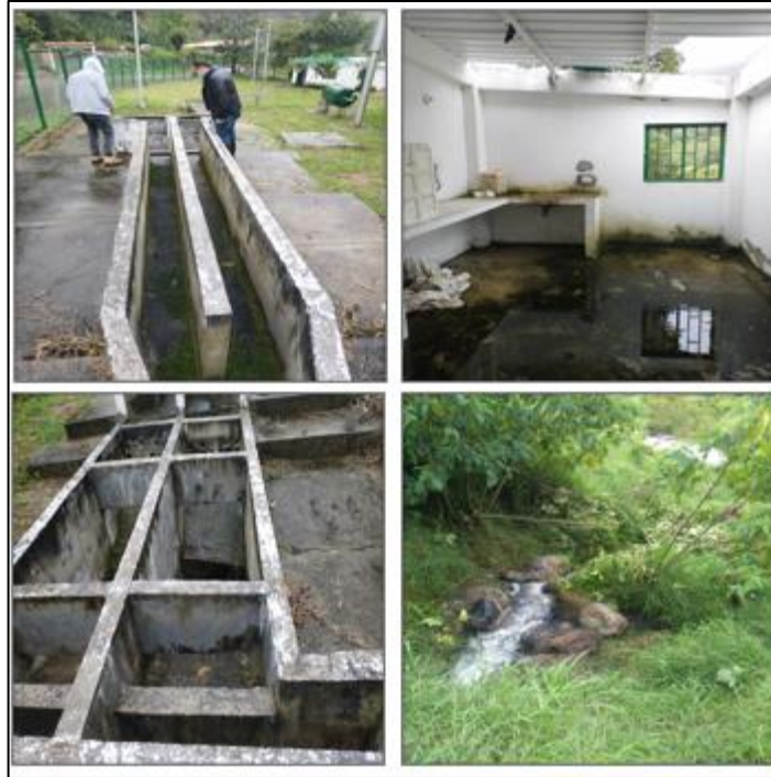
Figura 9. Evidencia Fotográfica visita PTAR TONA
