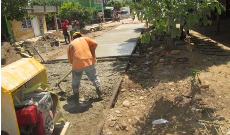
Figura 16. Fundición de las losas de concreto.
