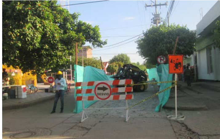
Figura 4. Cierre y señalización de la vía
