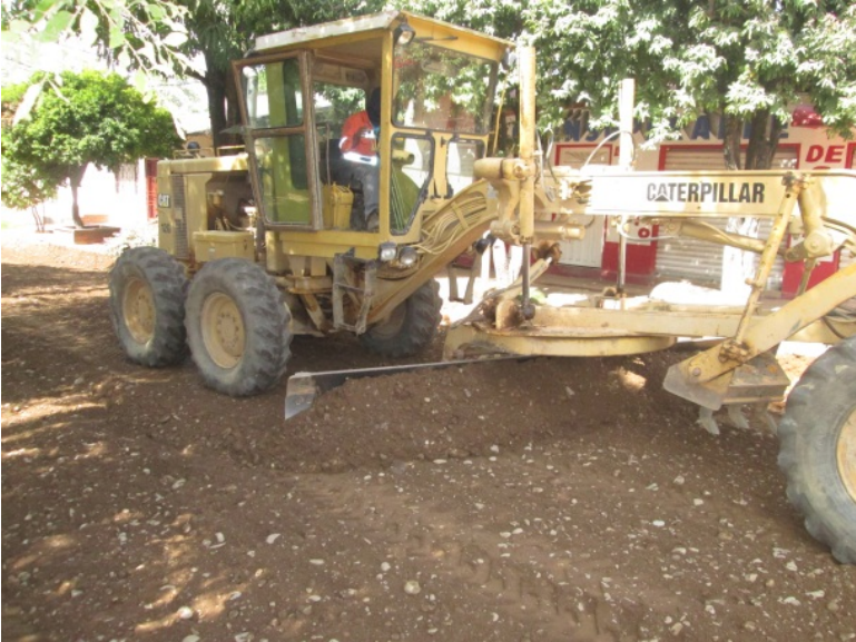
Figura 14. Instalación de subbase
