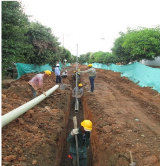
Figura 10. Reposición de alcantarillado
