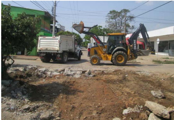
Figura 5. Cargue de volquetas donde el retro-cargador tiene más espacio para maniobrar.
