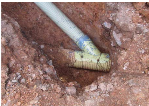
Figura 11. Instalación de accesorio silla yee de forma técnica.
