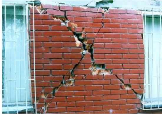
Ilustración 1 Daño Fuerte. tomado de Guía Técnica para la Inspección de edificaciones después de un Sismo
