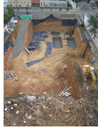
Figura 155. Vista Aérea, Septiembre 2008. Colocación de Solado de Cimentación.
