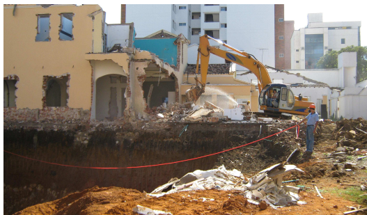
Figura 144. Demolición de Estructura Existente.
