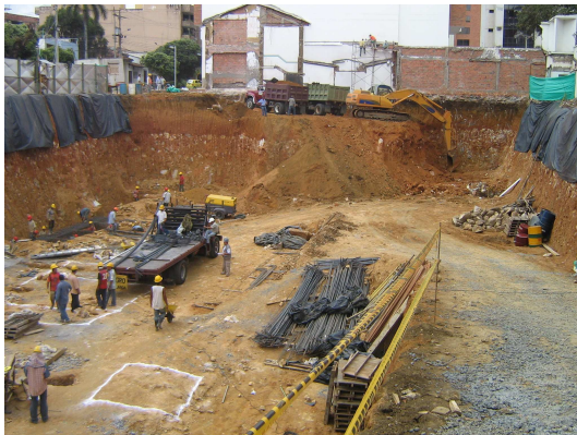
Figura 156. Recepción de Pedido de Acero con respectiva Verificación de Especificaciones.
