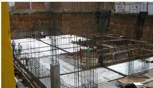
Figura 104. Instalación de Láminas en Acero para conformaron de la Plataforma en Steel Deck
