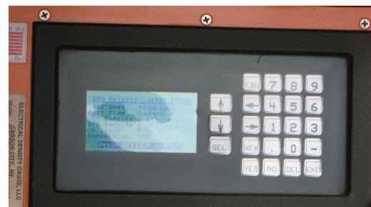
Figura 221. Lectura de Resultados de Compactación del Relleno en la Zona Cubierta.
