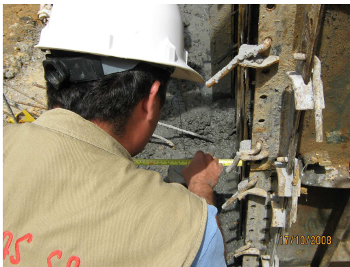
Figura 174. Aplomado Columna (Parte Inferior).
