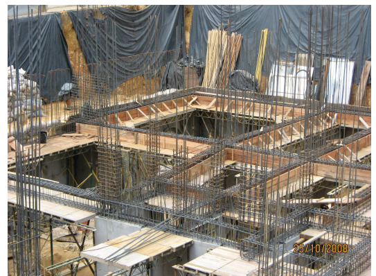
Figura 89. Armado y Encofrado de Vigas para el Sistema de Entrepiso.
