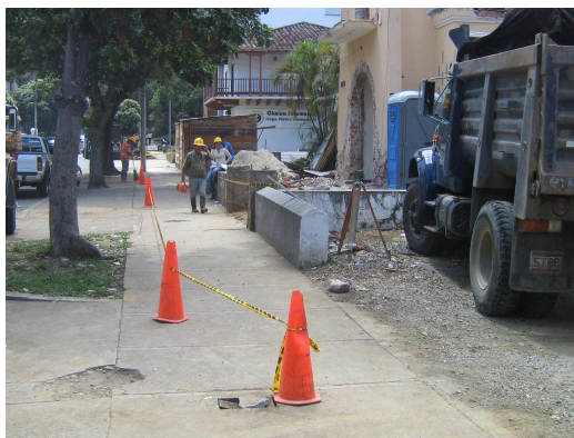
Figura 146. Actividades Preliminares, Topografía, Señalización Peatonal e Higiene.
