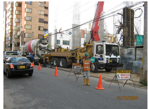
Figura 213. Señalización Vial durante Proceso de Fundición de Elementos Estructurales.
