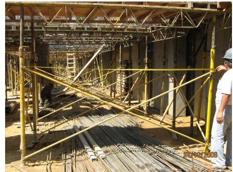
Figura 87. Verificación de Medidas del Sistema de Soporte.
