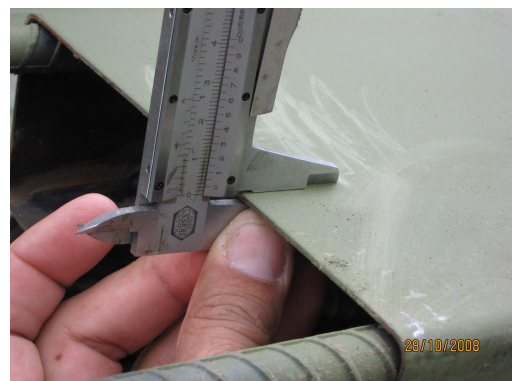
Figura 81. Verificación de Medidas y Especificaciones.
