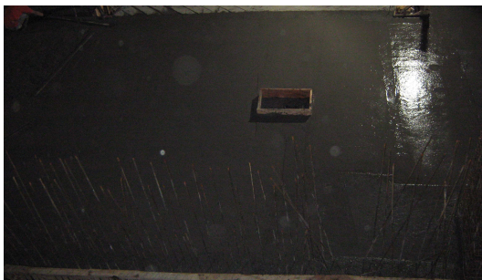
Figura 184. Acabado Placa Steel Deck usando Llana y Helicóptero. Caja de Perforación de Losa
