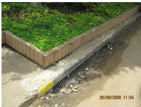
Figura 200. Instalación de Malla para Control de Sólidos en Alcantarillado Público.
