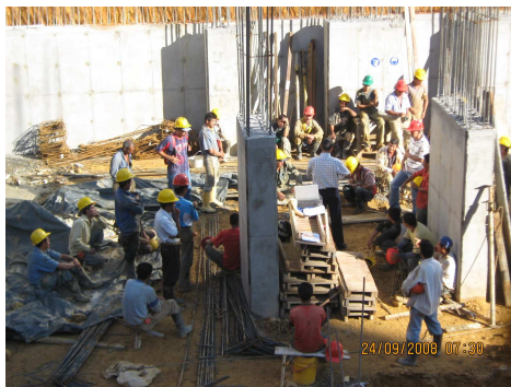
Figura 206. Charla de Seguridad Industrial a Personal de Obra.
