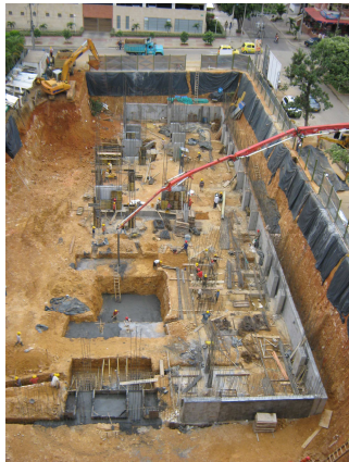
Figura 166. Vista Aérea de Obra, Octubre 2008. Colocación de Solado con Autobomba.
