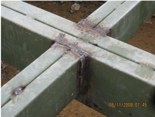
Figura 96. Detalle de Acabado en Unión de Viguetas por Conexión Tipo Soldadura.
