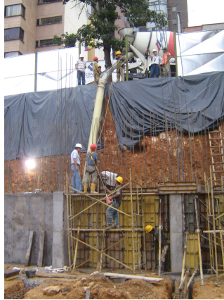
Figura 160. Fundición de Muro de Contención.
