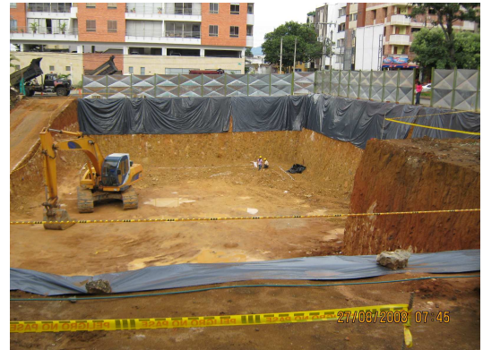
Figura 153. Protección de Taludes y Rampa. Señalización en Obra.
