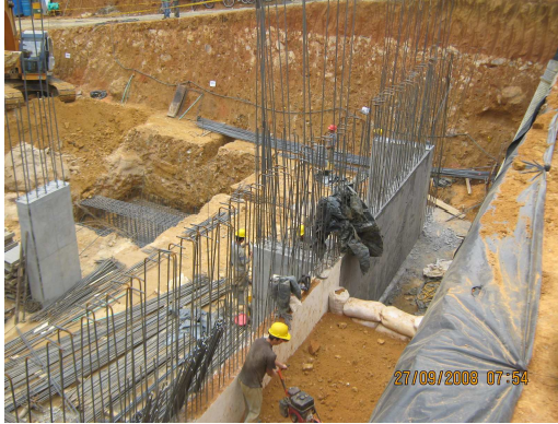
Figura 216. Proceso de Compactación de Relleno con el uso de Rana.
