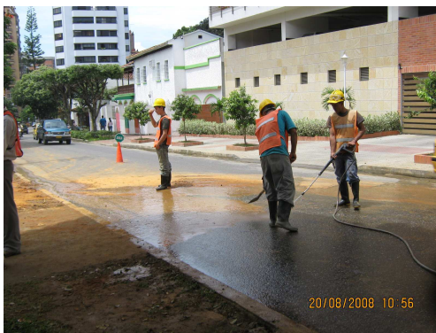
Figura 202. Limpieza de Vía por Contaminación en Proceso de Excavación.
