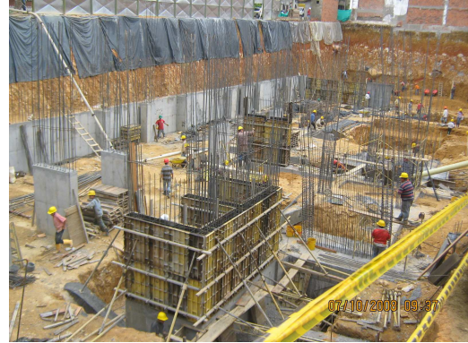
Figura 165. Encofrado de Foso de Ascensor.
