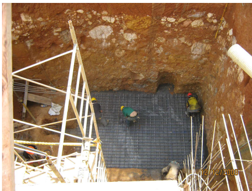
Figura 192. Armado de Refuerzo de Zapata.
