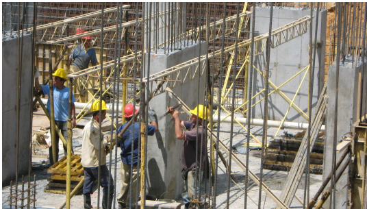
Figura 86. Instalación del Sistema de Soporte de Vigas y Losa de entrepiso.
