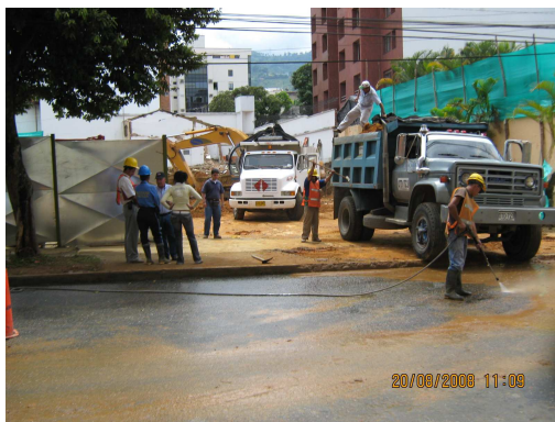
Figura 152. Control de Volquetas en Obra. Limpieza de Vías por Movimiento de Tierras.
