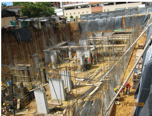
Figura 168. Proceso de Relleno, Octubre 2008.
