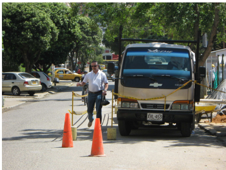
Figura 208. Instalación de Paso Peatonal Provisional por Descarga de Material.
