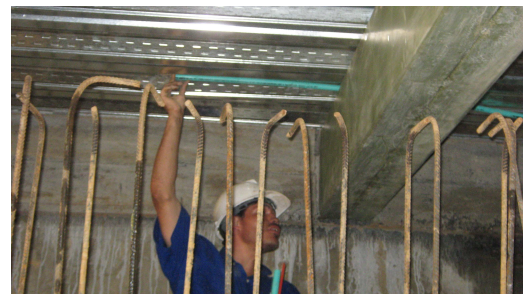
Figura 117. Instalación de Tubería Descolgada en la Parte Inferior de Losa en Steel Deck.
