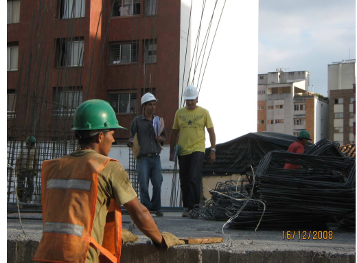
Figura 195. Inducción al Nuevo Auxiliar de Calidad de Obra.
