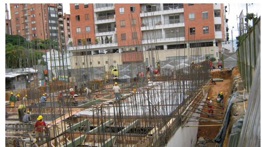
Figura 187. Proceso Relleno, Noviembre 2008. Instalación de Láminas y Viguetas en Acero.
