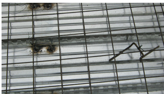
Figura 106. Detalle de Instalación de Malla por Retracción y Temperatura. Amarre de Conectores y Distanciadotes a Malla.
