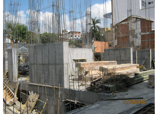
Figura 189. Estado General de Obra, Diciembre 2008.
