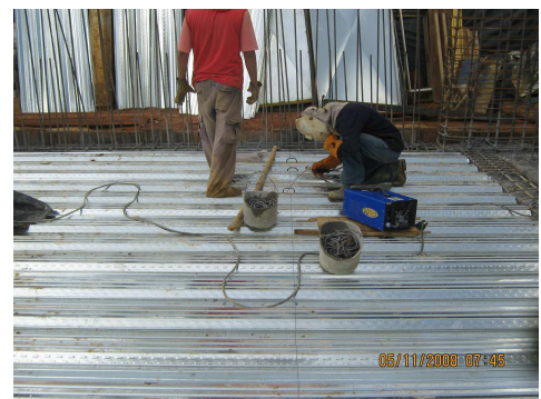
Figura 105. Instalación de Conectores de Losa mediante Soldadura.
