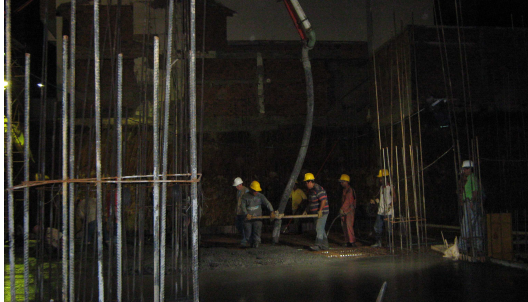
Figura 182. Fundición de Losa de Entrepiso en Sistema Steel Deck, usando Autobomba.
