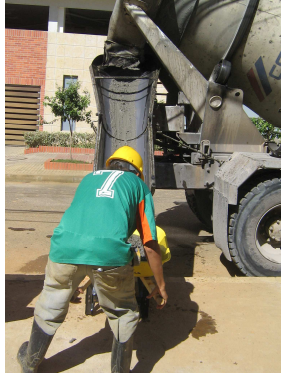
Figura 222. Mezcla de Concreto en Mixer y Toma de Muestra.
