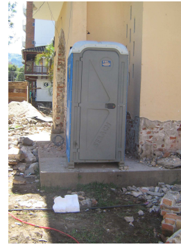
Figura 205. Instalación de Baño Portátil para Personal de Obra.
