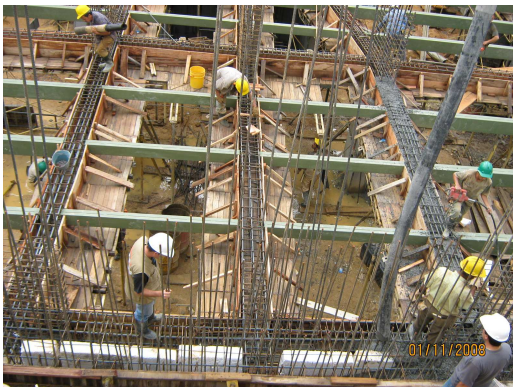
Figura 98. Fundición Monolítica de Vigas y de Uniones Viga - Vigueta, en entrepiso.
