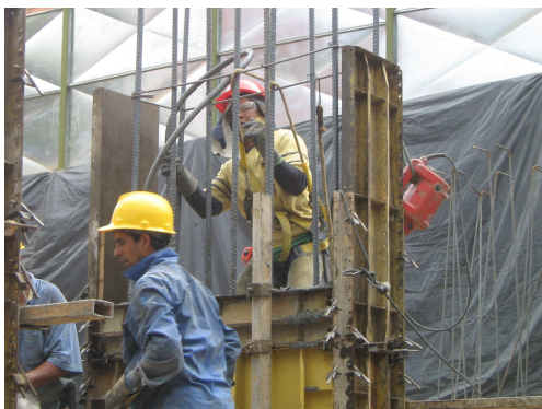
Figura 214. Vibrado de Columna. Utilización de los Elementos de Seguridad Indicados.
