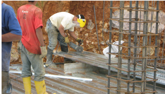
Figura 104. Instalación de Láminas en Acero para conformaron de la Plataforma en Steel Deck
