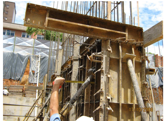
Figura 175. Aplomado Columna (Parte Superior).
