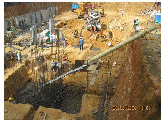
Figura 163. Fundición de Cimentación de Foso de Ascensor.
