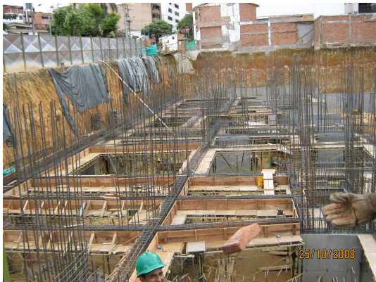
Figura 172. Armado y Encofrado de Vigas de Losa de Entrepiso.
