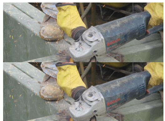
Figura 95. Eliminación de Residuos en Conexión Soldada de Viguetas en Acero
