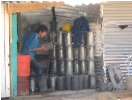
Figura 234. Traslado de Muestras de Concreto a Pila de Curado.
