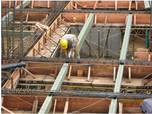
Figura 90. Instalación de Viguetas (Perfiles) en Sistema de Entrepiso Steel Deck.
