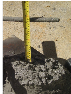
Figura 231. Lectura de Asentamiento del Concreto en Cuartos de Pulgada.
