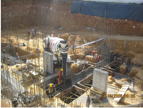
Figura 164. Fundición Estructura de Cimentación
