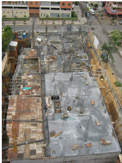
Figura 196. Vista Aérea y Estado General de Obra, Diciembre 2008.
