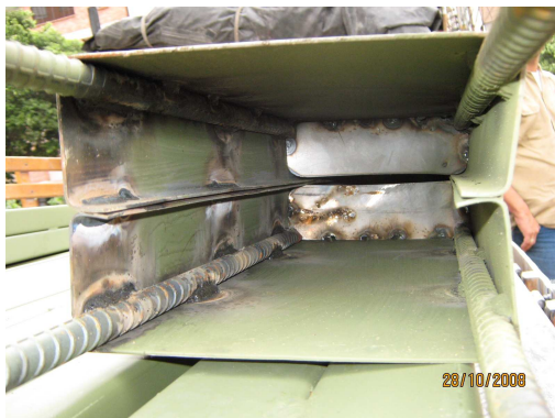
Figura 82. Tapa de Cierre y Bastones de Anclaje.
