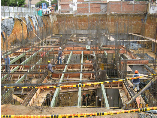
Figura 176. Instalación Viguetas en Acero para Conformación de Losa de Entrepiso Steel Deck.
