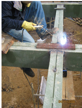
Figura 94. Unión de Viguetas en Acero por Conexión Tipo Soldadura.
