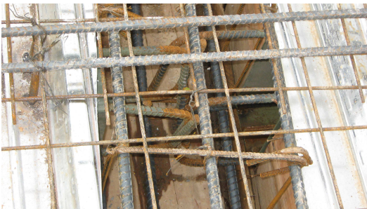
Figura 94. Unión de Viguetas en Acero por Conexión Tipo Soldadura.
