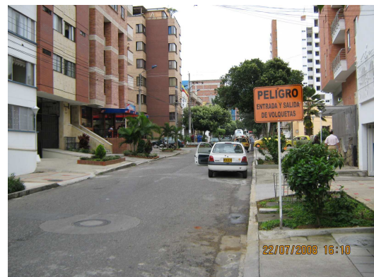
Figura 147. Instalación de Señales de Tránsito para Ejecución del Proyecto.
