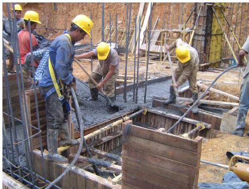
Figura 158. Fundición Estructura de Cimentación
