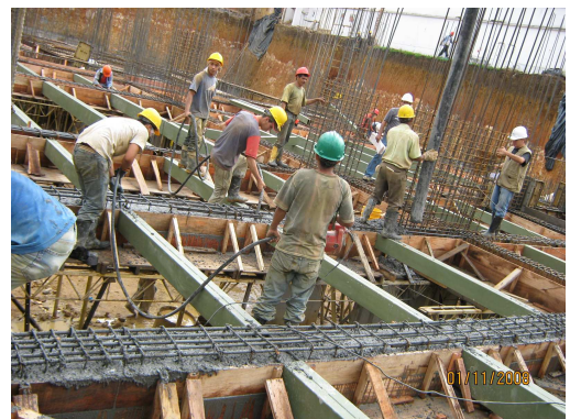
Figura 99. Vibrado en Fundición de Vigas y Viguetas, del Sistema Steel Deck.
