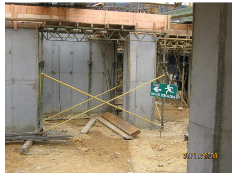
Figura 209. Demarcación de la Ruta de Evacuación de Obra.
