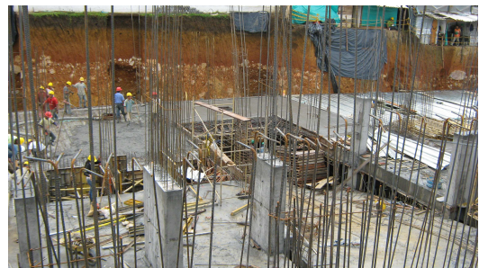
Figura 113. Fundición de Losa de Entrepiso en Sistema Steel Deck.
