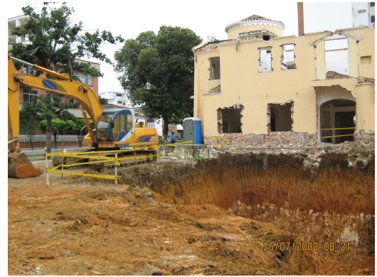
Figura 143. Proceso de Excavación.
