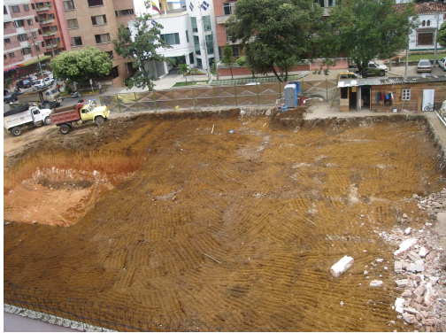
Figura 148. Vista Aérea, Agosto 2008. Terreno a Nivel de Descapote. Campamento de Obra.
