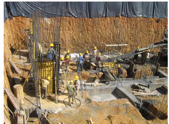
Figura 159. Fundición de Columna.
