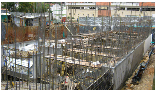
Figura 186. Resane y Aplicación de Capas de Impermeabilización en Muros de Contención.
