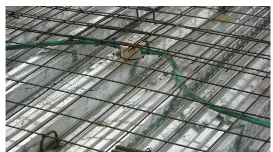
Figura 107. Detalle de Instalación de Red Eléctrica sobre Plataforma del Sistema de Losa en Steel Deck.
