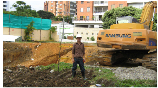
Figura 151. Instalación de Lona para Control de Material Particulado durante Excavación.
