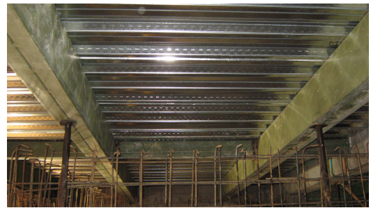
Figura 111. Apuntalamiento de Losa en Puntos Específicos de Viguetas.
