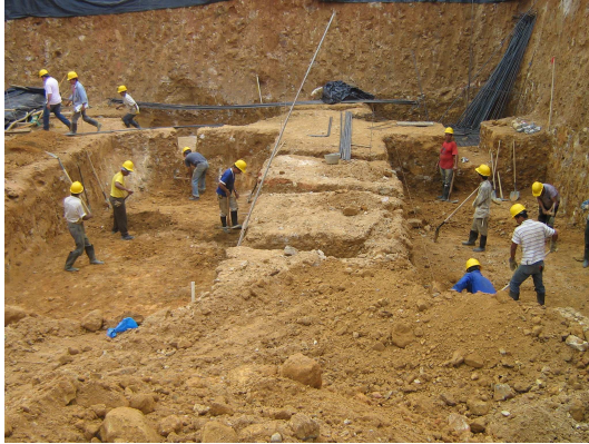
Figura 154. Excavación Manual para Conformación de Estructura de Cimentación de la Edificación.
