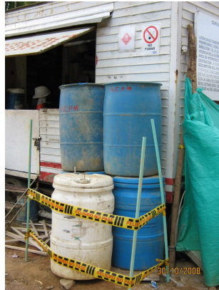
Figura 210. Manejo y Disposición de Combustibles en Obra.
