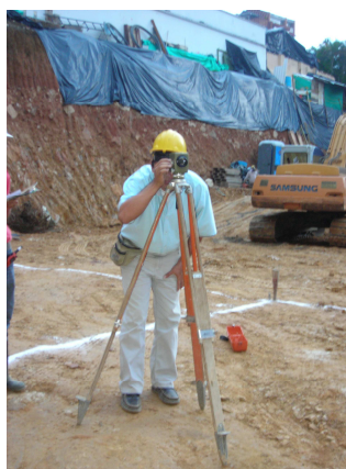
Figura 128. Ajuste del Nivel de Precisión.
