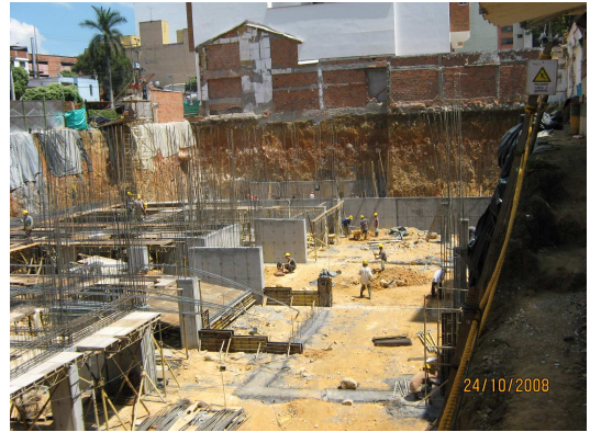
Figura 171. Estado General Obra, Octubre 2008.
