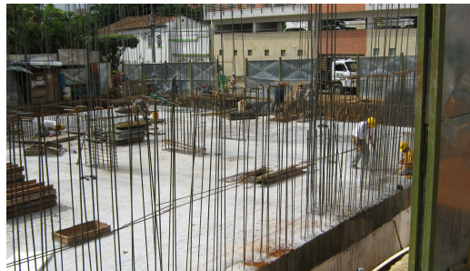
Figura 116. Puesta en Servicio de la Losa en Steel Deck, tras alcanzar su Resistencia. Función de Sistema Compuesto de Lámina Colaborante.
