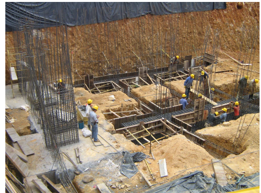
Figura 157. Armado de Refuerzo de Estructura de Cimentación.
