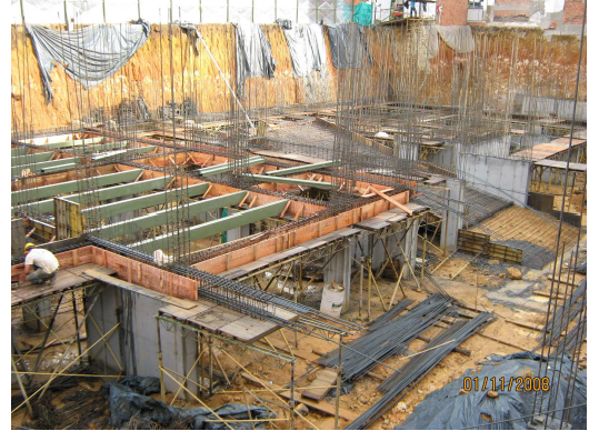
Figura 177. Armado de Rampa para el Acceso entre Niveles Adyacentes.
