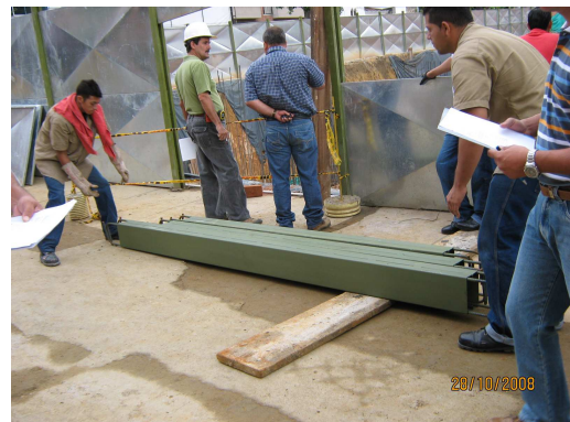
Figura 83. Descarga sobre Bases de Madera.
