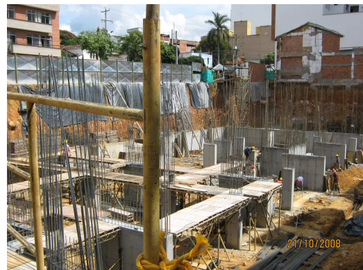
Figura 169. Estado General de Obra, Octubre 2008.
