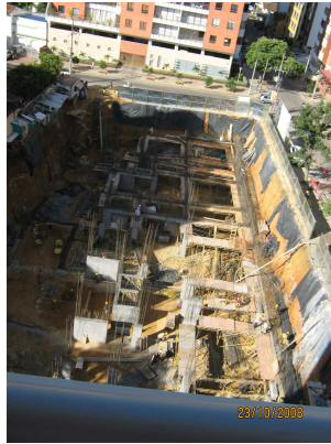
Figura 170. Vista Aérea de Obra, Octubre 2008.
