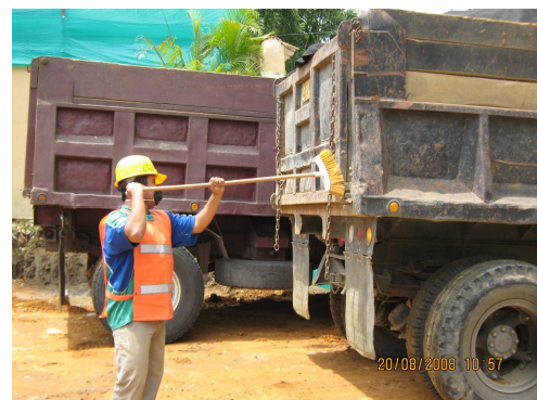
Figura 203. Limpieza de Volquetas en Movimiento de Tierras.
