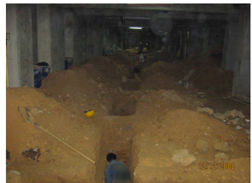
Figura 193. Excavación Manual. Conformación de Sistema de Alcantarillado Interno de Obra.
