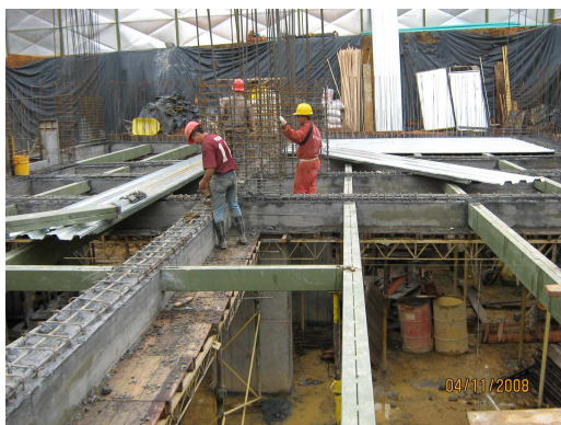
Figura 100. Desencofrado de Vigas. Esquema de Uniones tras Endurecer las Vigas.
