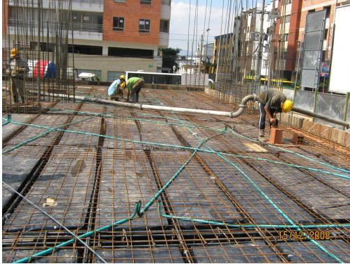
Figura 194. Instalación de Malla Electrosoldada y de Redes, en Placa de Sistema Tradicional.
