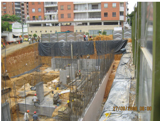
Figura 162. Proceso de Relleno y Estado General de Obra, Septiembre 2008.
