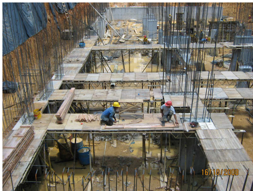
Figura 88. Entablarado para Conformación de Vigas y Losa de Entrepiso.
