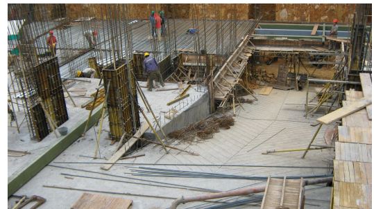
Figura 185. Puesta en Servicio de Rampa de Acceso en Entrepisos.
