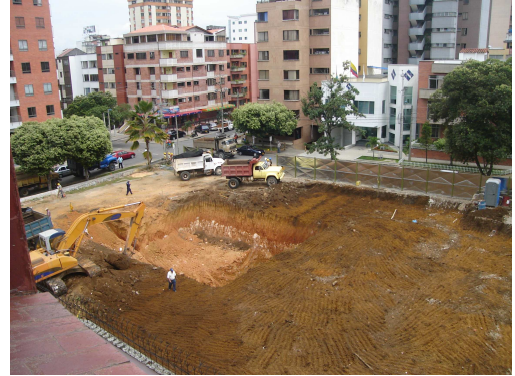
Figura 149. Excavación Preliminar para Comprobación del Estudio de Suelos.
