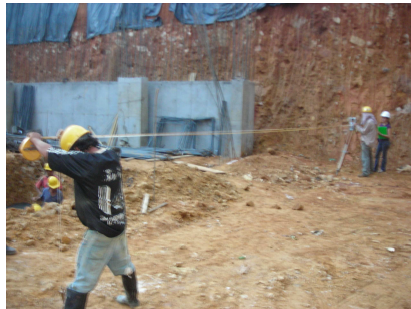
Figura 123. Verificación Teodolito: Cierre de poligonal.
