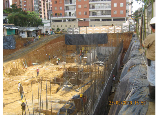
Figura 161. Resane y Aplicación de Capas de Impermeabilización en Muros de Contención.
