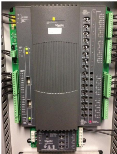
Figura 15. Controladora i2920 de la plataforma Andover Continuum Infinet II
