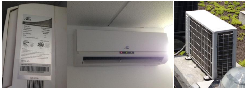
Figura 18. Instalación de aire acondicionado en dirección E3T y CCTV
