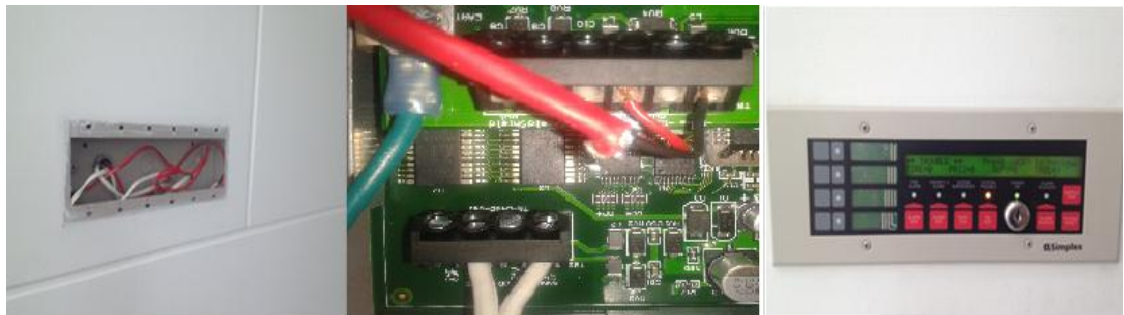
Figura 37. Instalación del anunciador remoto
