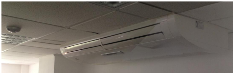
Figura 20. Instalación de aire acondicionado en sótano
