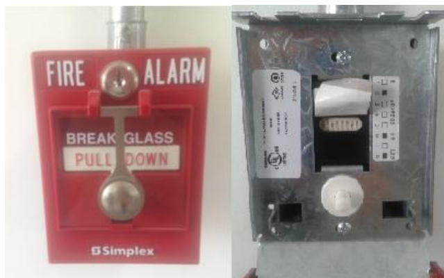
Figura 38. Estación manual direccionable Simplex 4099-9002
