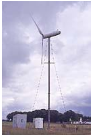
Figura 32. Torre de mástil tensado
