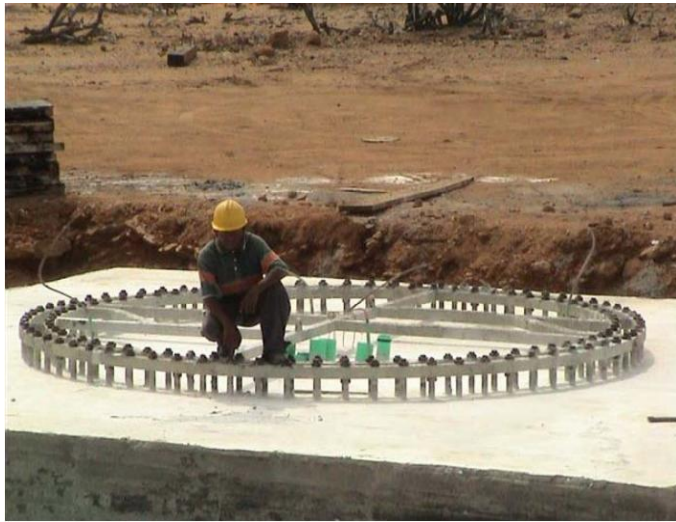
Figura 33. Cimentación de una de las torres del parque jepirachi (Guajira-Colombia)
