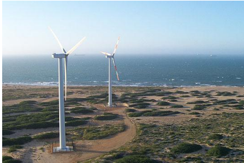
Figura 7. Dos turbinas eólicas de 1.3 MW. Jepírachi, La Guajira
