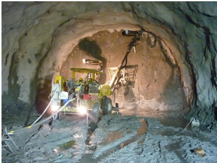
Figura 7. Jumbo, maquinaria de perforación
