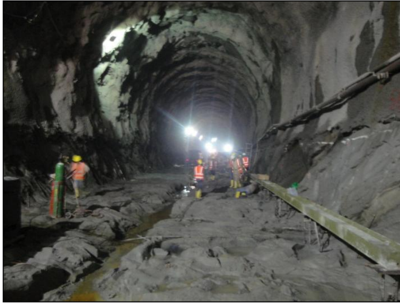
Figura 24. Avance en excavación del túnel de desvío 2
