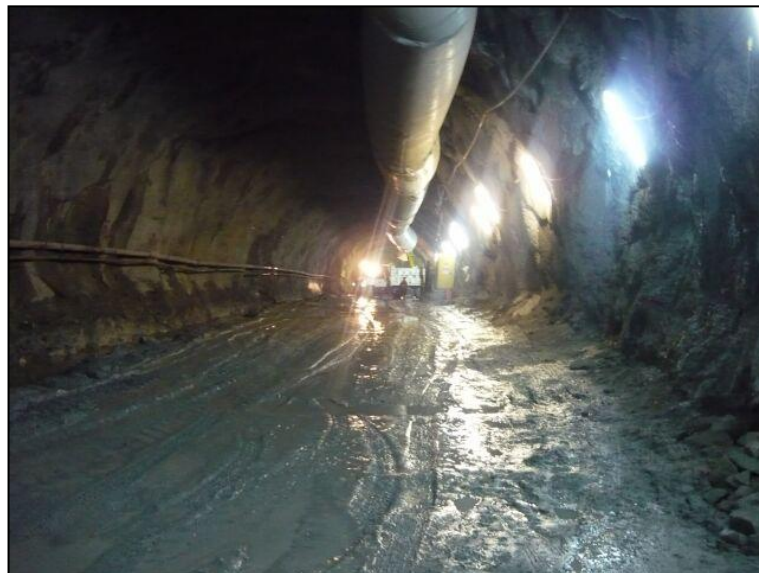
Figura 22. Túnel de desviación 1
