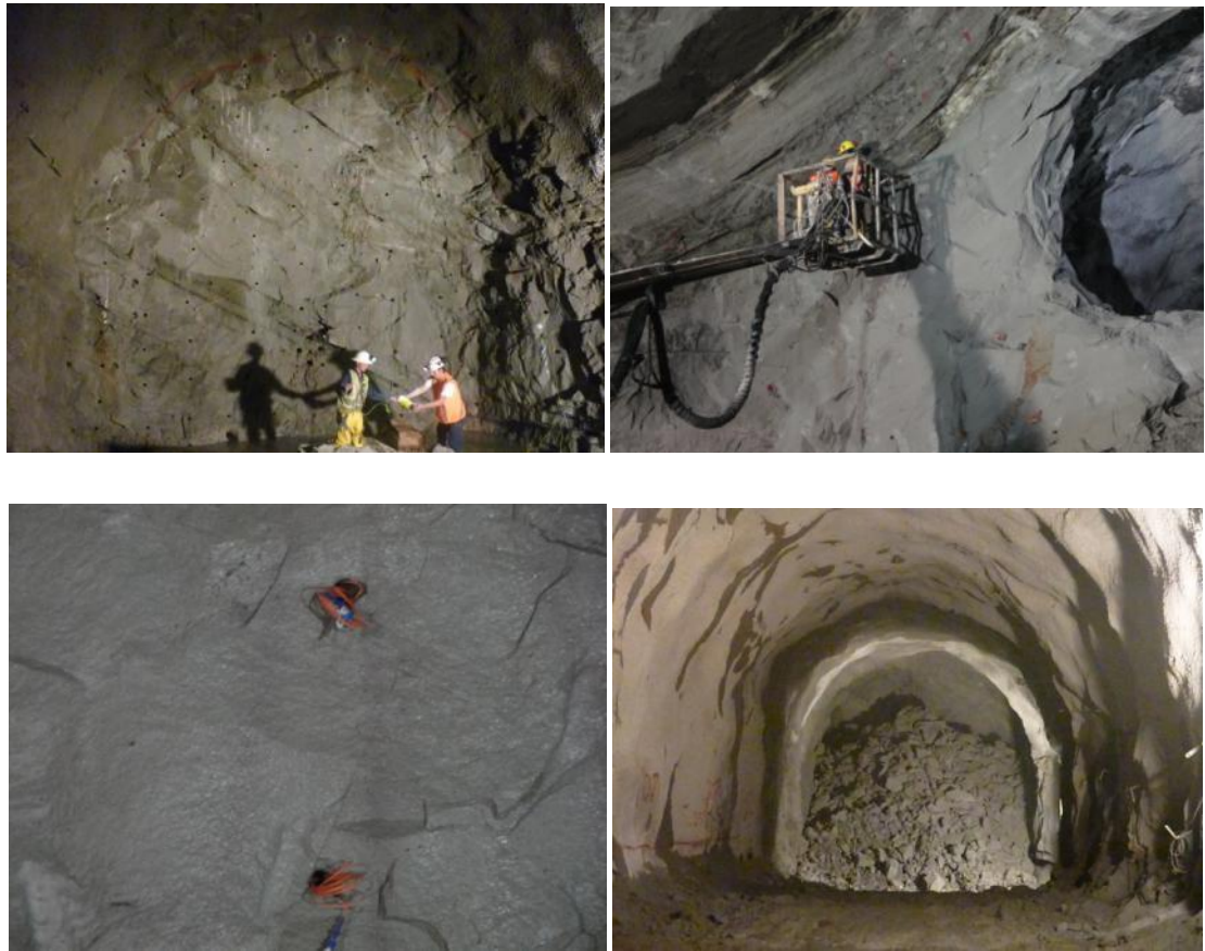
Figura 9. Proceso de voladura para bóveda en los túneles de desvío
