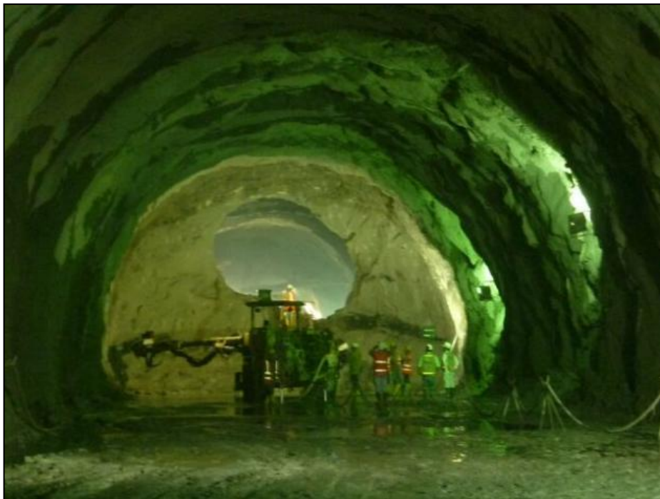
Figura 21. Túnel de desviación 2, encuentro de excavaciones
