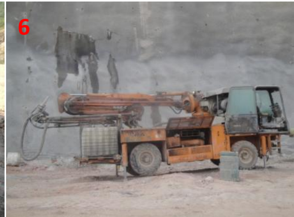
6. Lanzadora de concreto
