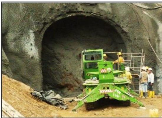
Figura 5. Excavación en ventana 1
