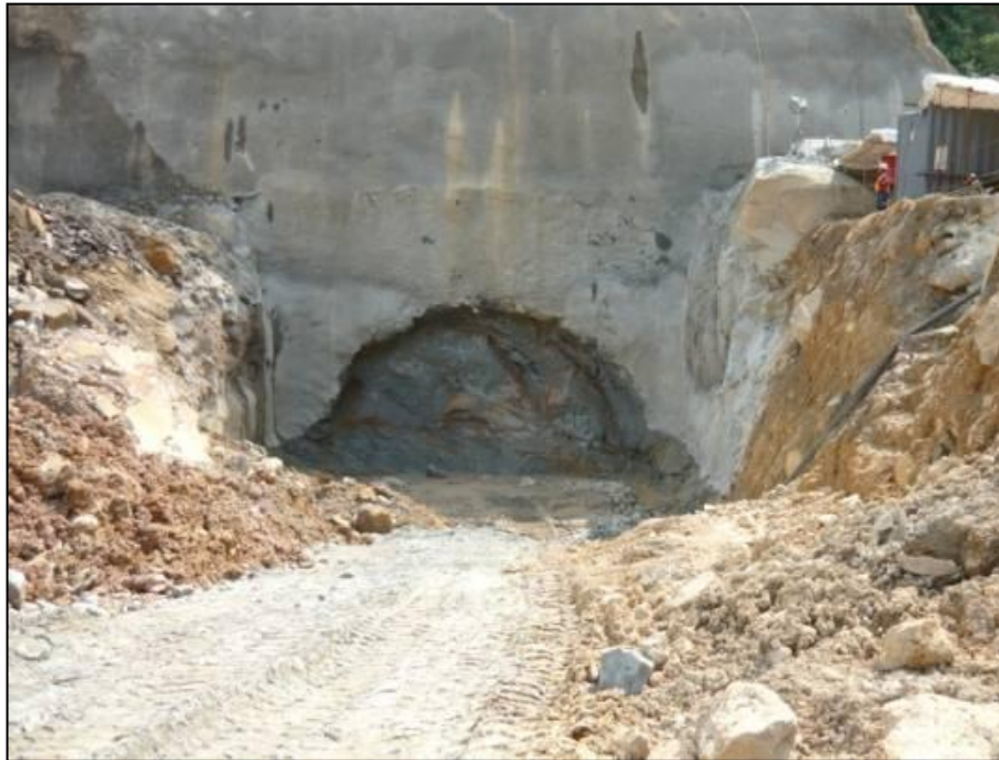
Figura 23. Emportalamiento bóveda túnel de desviación 2
