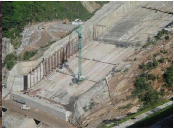
Construcción del vertedero
