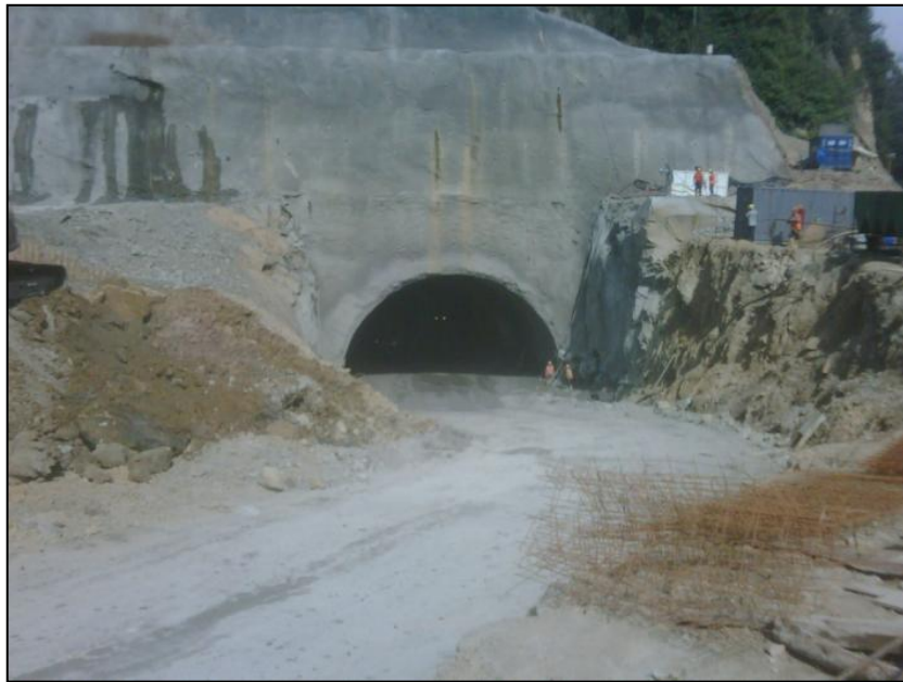
Figura 25. Trabajos en portal de entrada túnel de desviación 2
