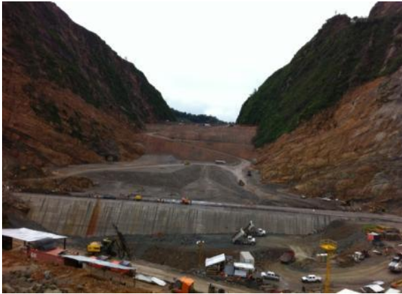
Construcción de la Presa
