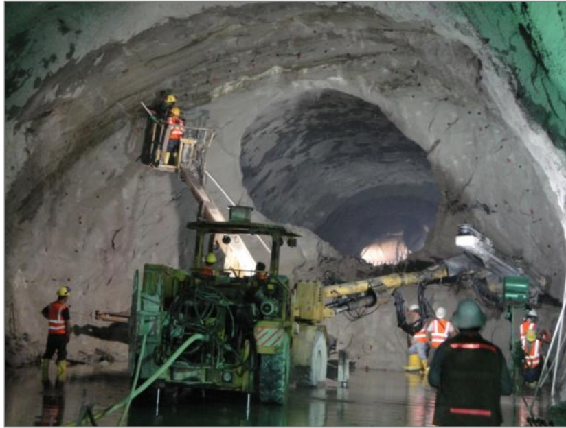
Figura 20. Encuentro de excavaciones túnel de desvió 2 el día 15 de abril
