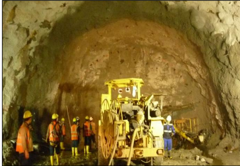
Figura 19. Excavación túnel de desviación
