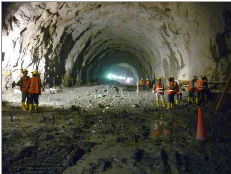
Figura 10. Voladura para banqueo en los túneles de desvío
