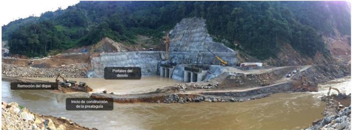
Figura 18. Maniobra de desvío del río Sogamoso
