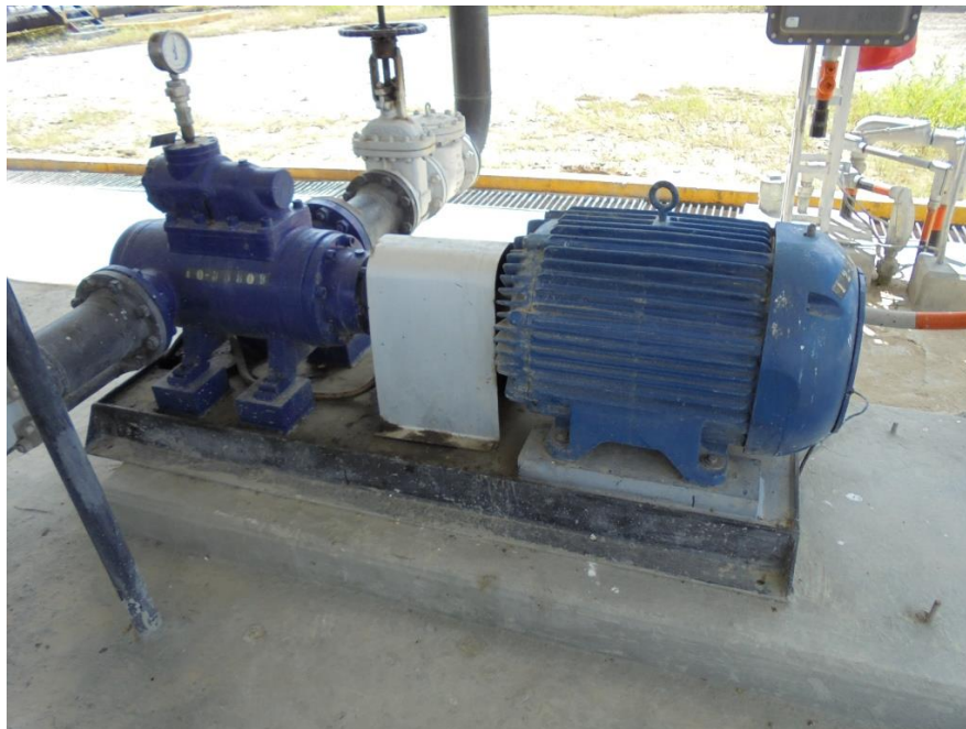
Figura 4. Unidad de bombeo cargadero carrotanques.
